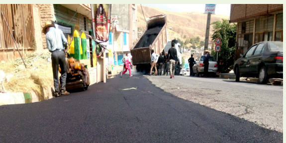
♦ زیرسازی و آسفالت خیابان اصلی معلم کلایه تا انتهای شهر
