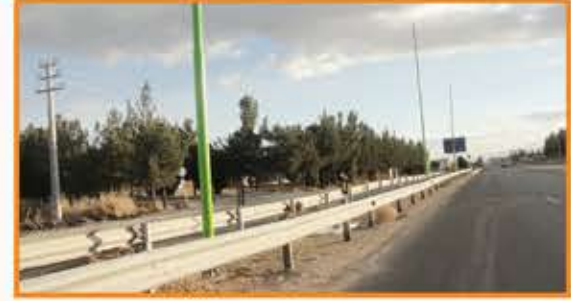
اجرای تیر برق روشنایی تقاطع حادثه خیز پمپ بنزین
