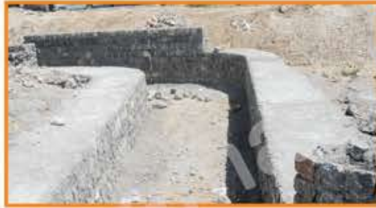
اجرای قسمتی از مسیل جاده مسکن مهر
