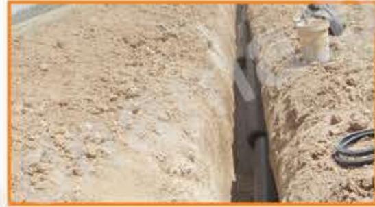
اجرای خط انتقال پساب
