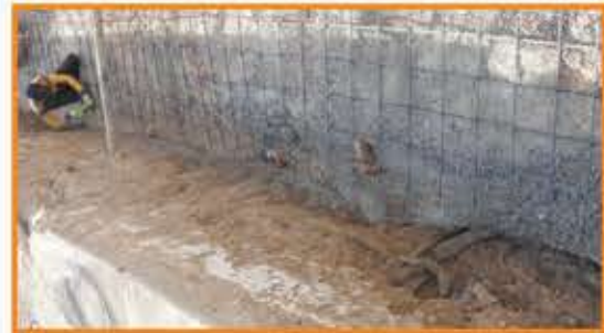
اجرای فاز دوم کانال سید جمال
