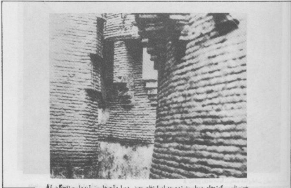
خوزستان - گوشه‌های دیوار بخ شده بعد از ارتفاع معینی دوباره آجرها به‌ش آمده است (توشگان) ▲
