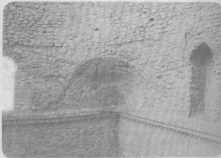
آتشکده فیروزآباد - نمونه گوشه سازی فیلیوش A
