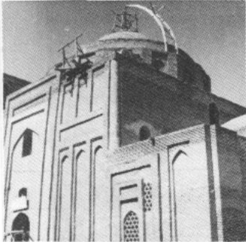
مشهد- طرس بنای هارونیه اجرای (خود) کتبدبه شیوه متداول منطقه
