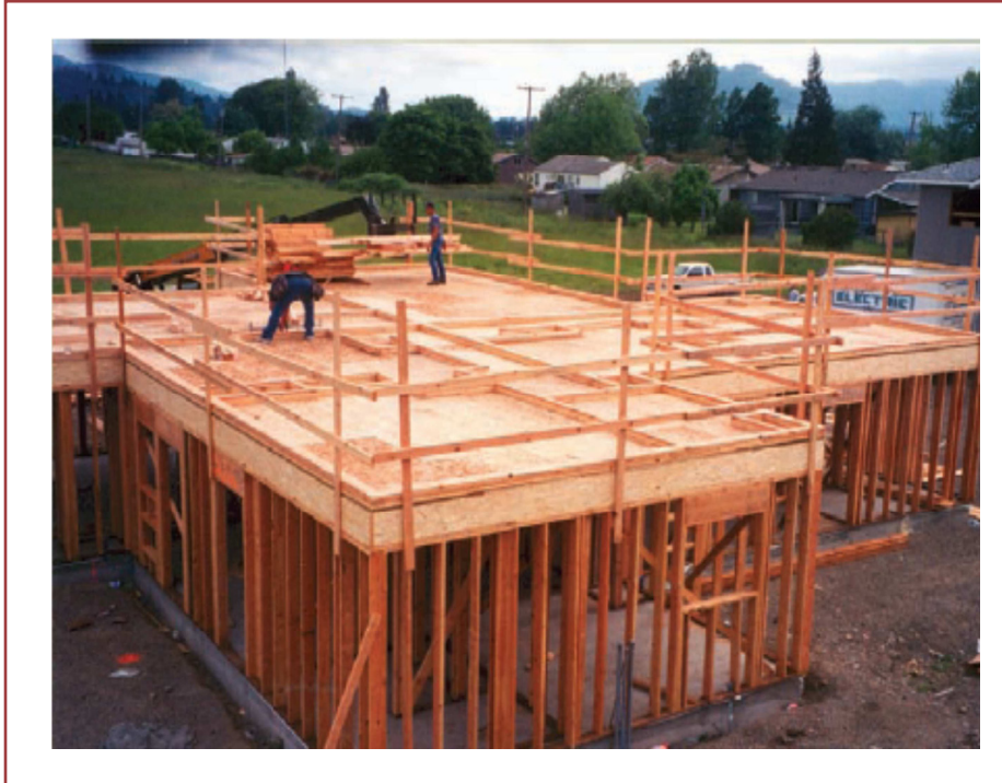
شکل ۴۶ - سیستم های نرده حفاظتی موقت که حفاظت کارگران را از سقوط تسهیل می کند.
