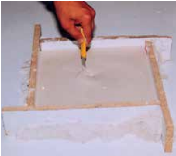
تصویر ۲- د- خارج کردن هوا از دوغاب گچی
