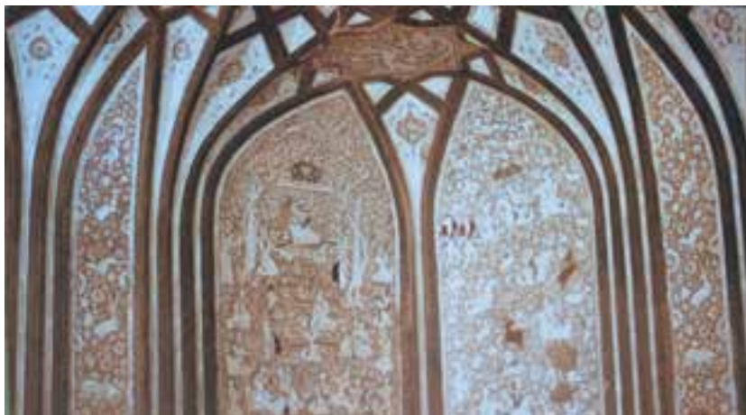
تصویر ۳۱- بخشی از یک ساختمان قدیمی در نایین - نیمه دوم قرن دهم هجری (صفویه)
