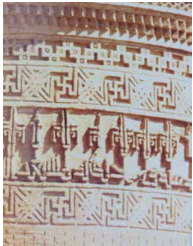
تصویر ۲۳- ب- آجرکاری برج رصدخانه سمنان - دوره سلجوقی
