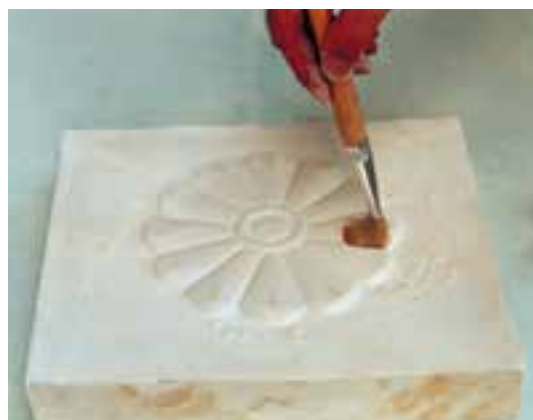
تصویر ۴-ز - تمیز کردن نقش برجسته با قلم مو
