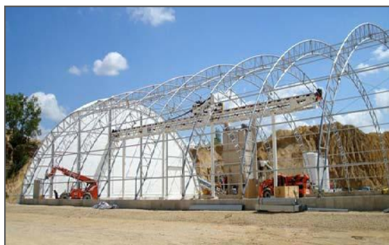
تصویر شماره ۳-۷-۱۹: انبار نمک در حال ساخت
