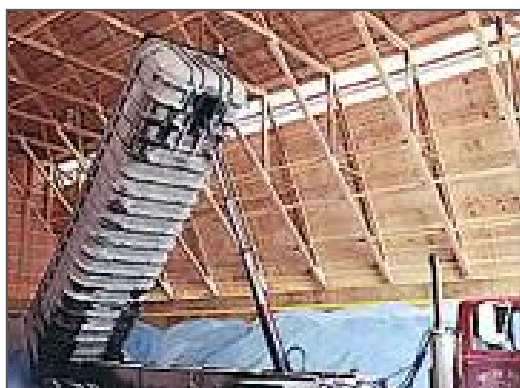
تصویر شماره ۳-۷-۵: انبار نمک- فضای داخلی
