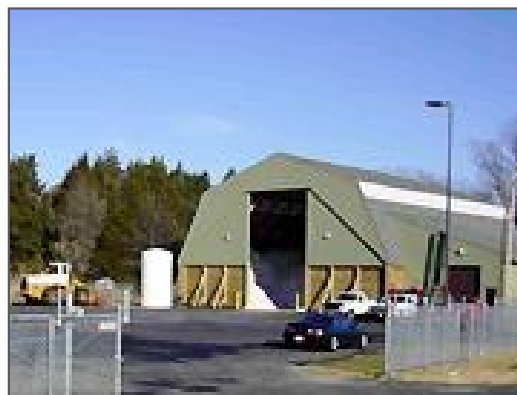
تصویر شماره ۳-۷-۲: انبار نمک
