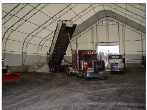
تصویر شماره ۳-۷-۲۳: انبار نمک - فضای داخلی
