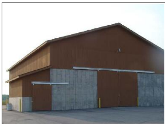
تصویر شماره ۳-۷-۲۷: انبار نمک
