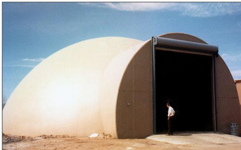
تصویر شماره ۳-۷-۱۶: انبار نمک بزرگراه کولورادو
