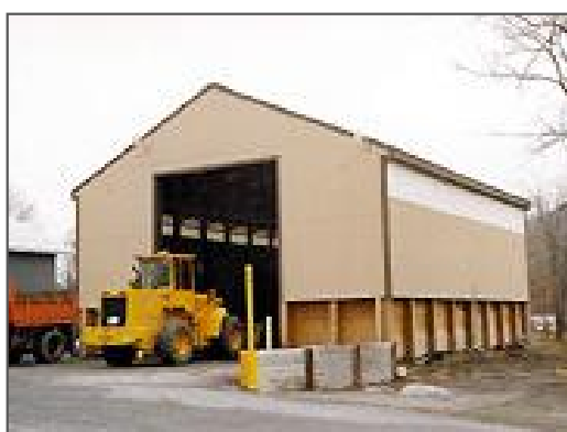
تصویر شماره ۳-۷-۱۲: انبار نمک کوچک با ظرفیت ۵۰۰ تن تصویر شماره ۳-۷-۱۳: انبار نمک کوچک با ظرفیت ۵۰۰ تن
