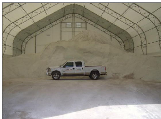
تصویر شماره ۳-۷-۳۵: انبار نمک - فضای داخلی
