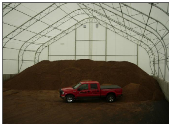
تصویر شماره ۳-۷-۳۶: انبار شن - فضای داخلی
