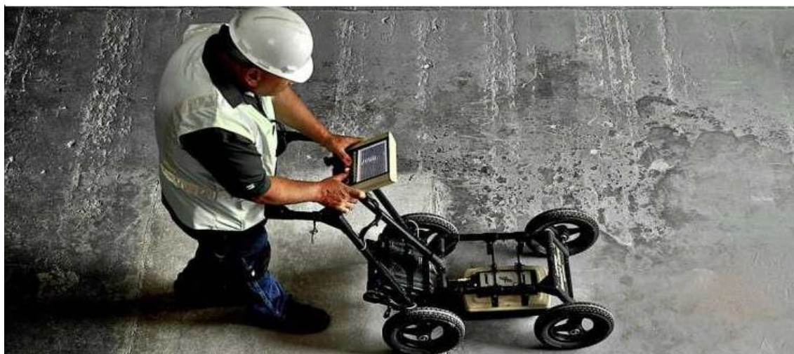
شکل ۳-۱: نمایش نحوه انجام عملیات GPR
