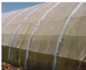
عایق‌کاری اجزا فولادی با رنگ سفید پلاستیکی
