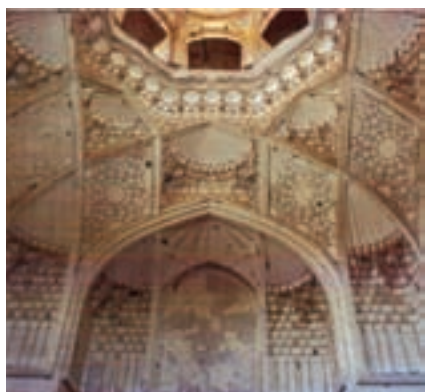
▲ شکل ۳-۱۱ - الف - نمای داخلی مدرسه غیائیه
