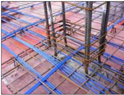
ساختن پل با بتون تقویت شده
