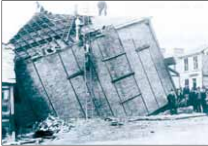
فرو نشستن زمین در بالای یک محفره نمکی
