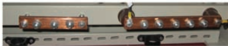
شکل ۱۶-۳ اتصال پیچی
