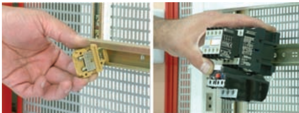
شکل ۵-۶۷ نصب کنتاکتور و ترمینال روی ریل
