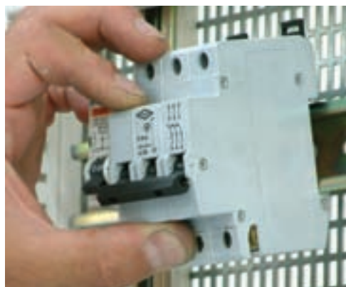
شکل ۹-۲- طرز قرارگیری فیوز مینیاتوری روی ریل
