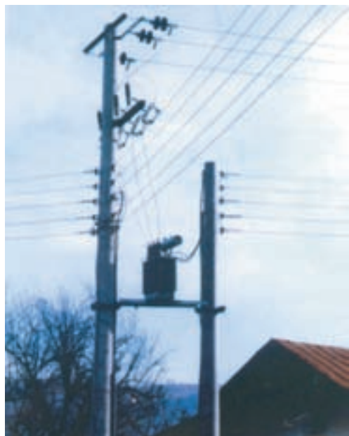
شکل ۷-۱ تبدیل ولتاژ ۲۰ کیلو ولت به ۴۰۰ و ۲۳۰ ولت
