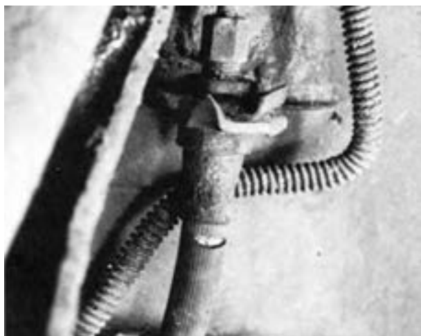
شکل ۱-۶۹- کنترل لوله‌ها و اتصالات
