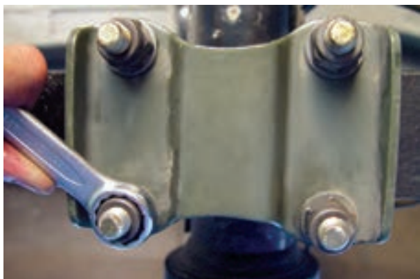
شکل ۳-۶۶- باز کردن مهره‌های کرپی‌ها (پیچ‌های U شکل)
