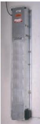
شکل ۳-۲۶- دماسنجه کنترل کننده پمپ آب
