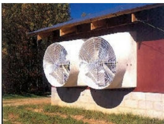
شکل ۱۸-۳- هواکش روی دیوارهای جانبی سالن پرورش طیور
