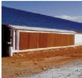
در مناطق گرم، سالن‌های پرورش طیور باید خنک شوند، بدین منظور از تجهیزات خنک کننده استفاده می‌شود. رایج‌ترین روش، استفاده از هواکش و پوشال است. در این روش، بر روی دریچه‌های ورودی هوا بر دیواره جانبی سالن
