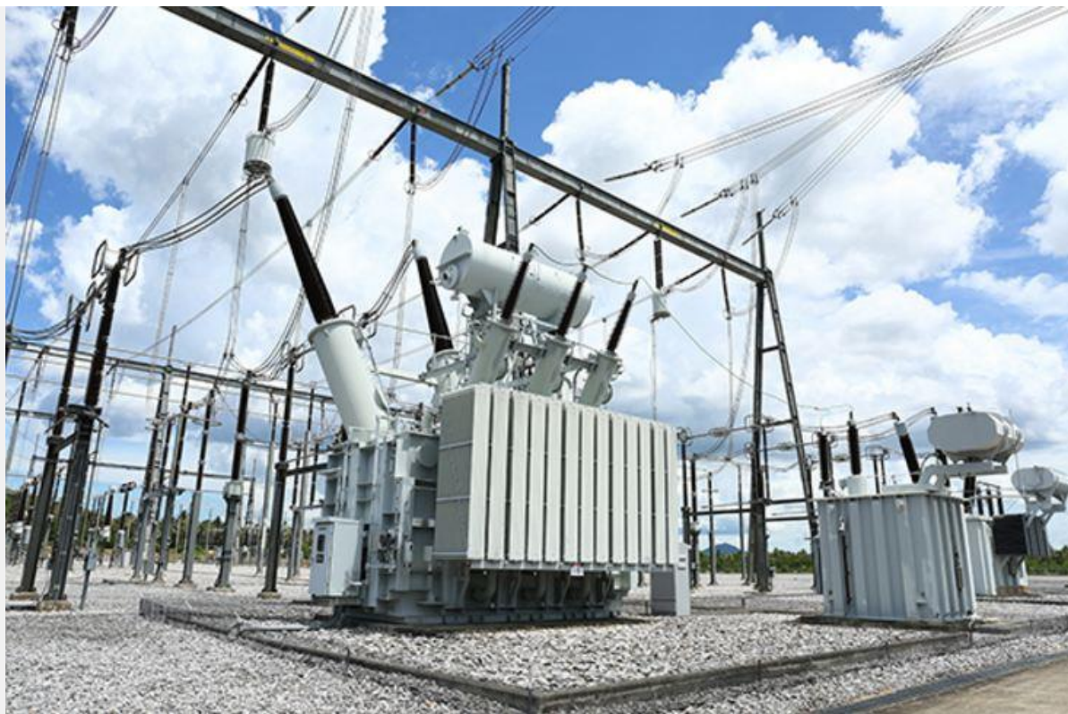
ترانسفورماتورها مهمترین تجهیزات شبکه انتقال هستن
