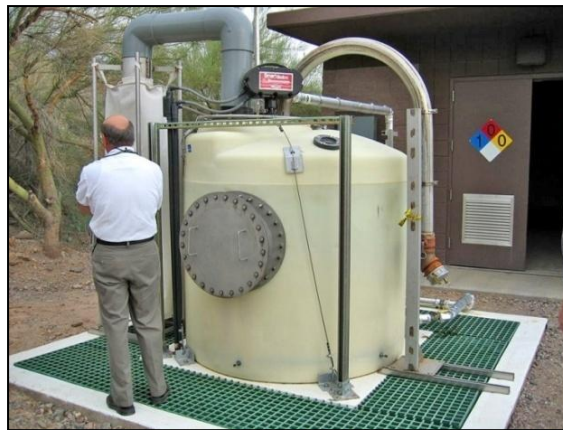
تصویر شماره ۲-۳-۴: در نظر گرفتن کانال جهت جمع‌آوری نمک مایع سرریز شده
