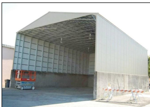
تصویر شماره ۲-۳-۲: انبار نمک با ترکیب دیوارهای بتنی و سازه سبک فلزی با پوشش گالوانیزه
