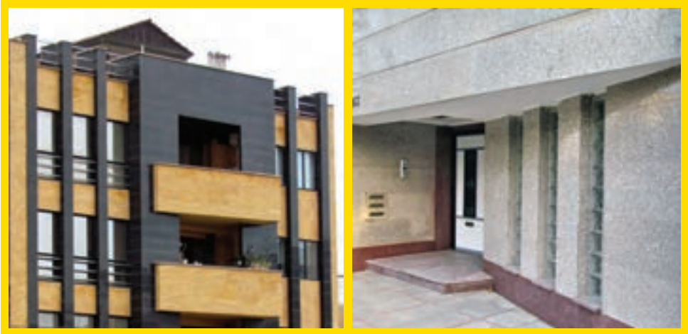
(ب) نمای سنگی ساختمان
