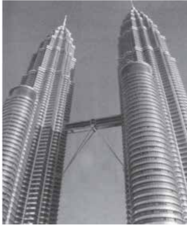
شکل ۱۴۹- برج دوقلوی پتروناس در مالزی
