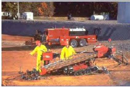
سوراج کاری زیر مخزن به منظور نصب آندهای اعمال جریان
