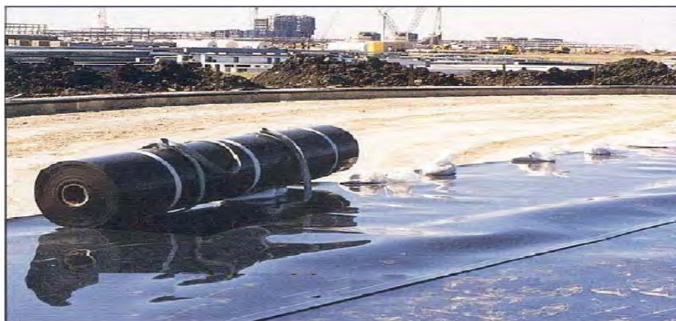
شکل 7. اعمال پوشش بر روی فندآسیون محل نصب مخزن Above ground
