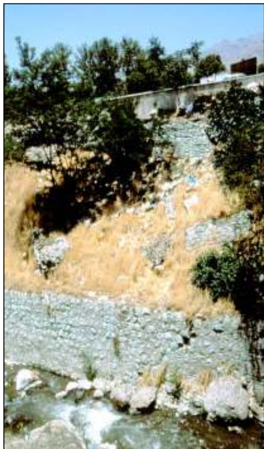
تصویر ۲۴: انباشت زباله در کناره‌های مسیل مقصودبک این امر منجر به آلودگی خاک و ریزش و نفوذ تدریجی زباله‌ها و آلودگی‌های ناشی از آن به درون آب می‌گردد.
