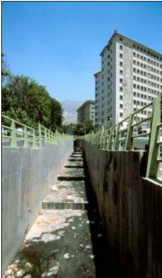
تبدیل رودخانه‌ها به کانال‌های بتنی احتمال انباشت زباله‌ها و حضور آنها را خصوصاً در مواقع کم آبی یا بی آبی تشدید می‌نماید. (مسیل ولنجک- خیابان الف)
