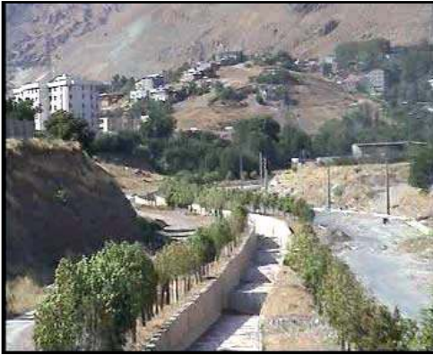
مسیل دارآباد (دید جنوب به شمال): این مسیل در نزدیکی بزرگراه ازگل به یک کانال بتنی مبدل شده که در دو طرف آن مسیر سواره در دست احداث است، حجم وسیع فضای سبز در حاشیه رودخانه در مجاورت کانال به دو ردیف چنار محدود شده است.
