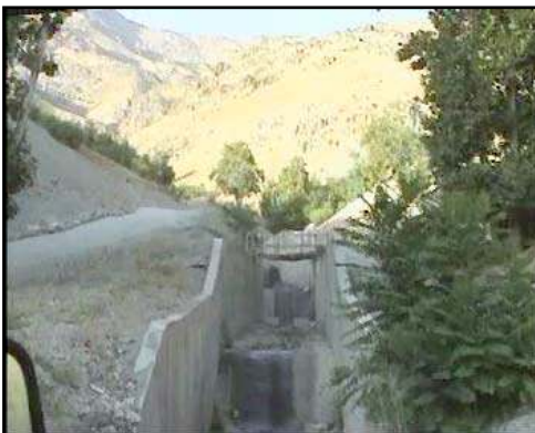
مسیل گلابدره (دید جنوب به شمال): رودخانه گلابدره در بخشی از مسیر خود به یک کانال بتنی تبدیل شده است.
