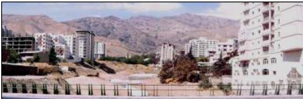
مسیل ولنجک (دید جنوب به شمال): بخش اعظم رودخانه ولنجک در شهر به یک کانال جمع آوری آبهای سطحی مبدل شده است.
