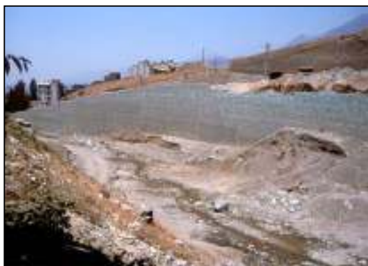
تصویر ۳۳: ساخت و ساز بدنه‌ها و بالادست، منجر به از بین رفتن بستر طبیعی رودخانه می‌شود. ضمن آنکه پتانسیل انباشت زباله و نخاله‌های ساختمانی را در درون بستر و کناره‌ها، افزایش می‌دهد. (رودخانه لارک)
