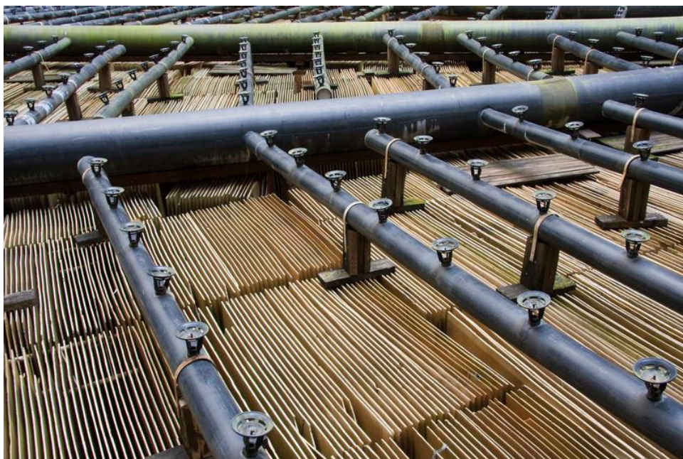
تصویر شماره ۱: نمونه پکینگ چوبی برج خنک کننده
