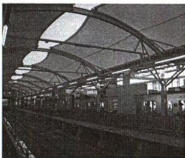
شکل ۳-۸ - سقف خودتمیزشونده در ایستگاه قطار ماتسوشیمای ژاپن - ۲۰۰۸
