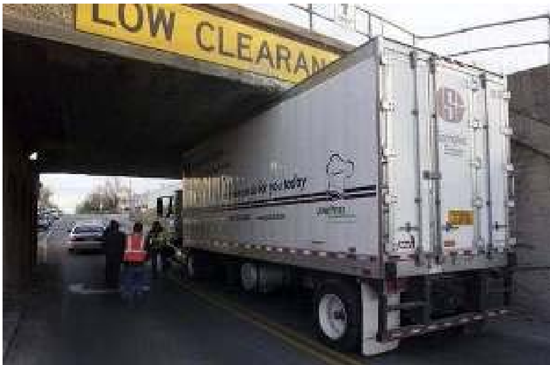
(شکل ۲-۱۱) برخورد قسمت فوقانی بارگیر تریلی با سازه زیرگذر پل
