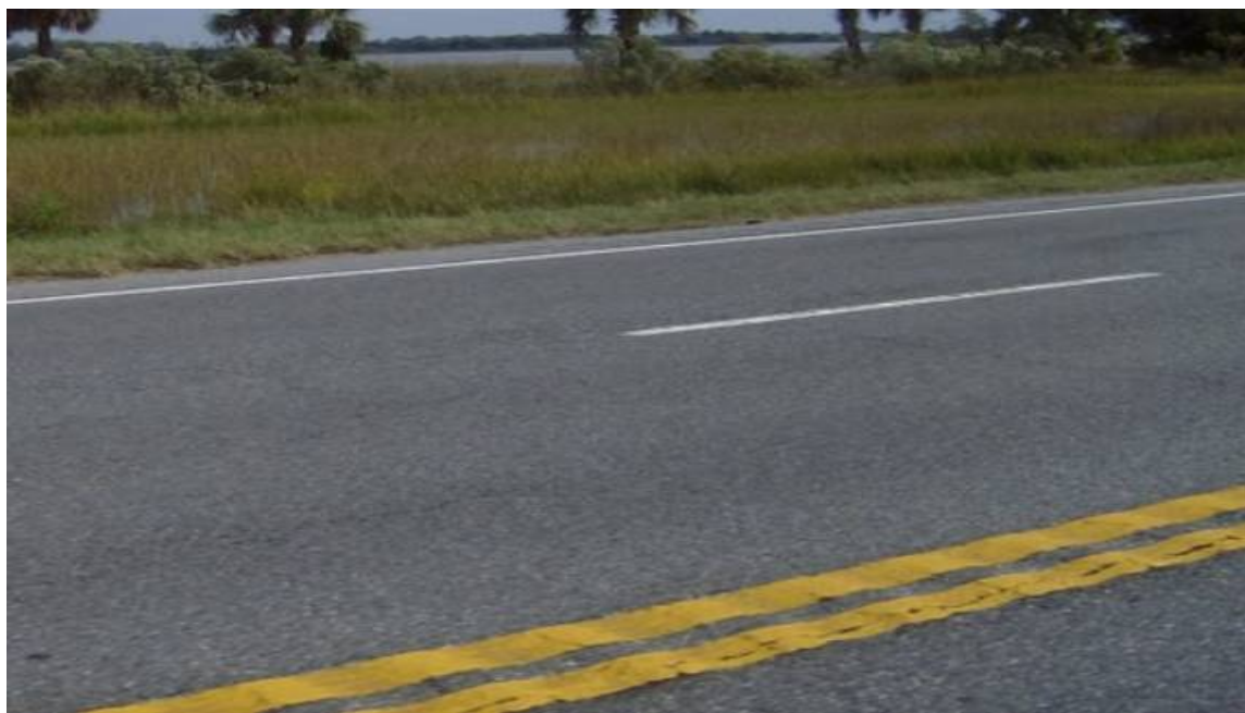
(شکل ۲-۱۹) تخریب رویه روسازی (فیتله شدن رویه) به دلیل ترمز وسایل نقلیه باربری
