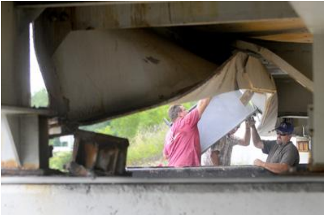
(شکل ۲-۱۲) برخورد بار با تیرهای پل و آسیب دیدگی کامل سازه زیرین دهانه اصلی پل
