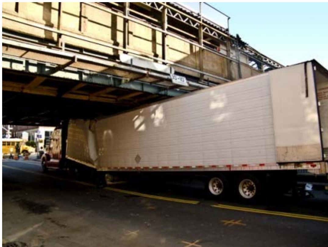
(شکل ۲-۱۲) برخورد قسمت فوقانی بارگیر با تیرهای زیرپل و آسیب دیدگی پل و بارگیر
