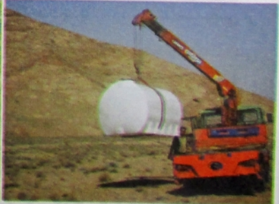
▼ نصب تانکر پلی اتیلن جهت آبرسانی به وحوش ▼ یارامشک - منطقه هنگام
