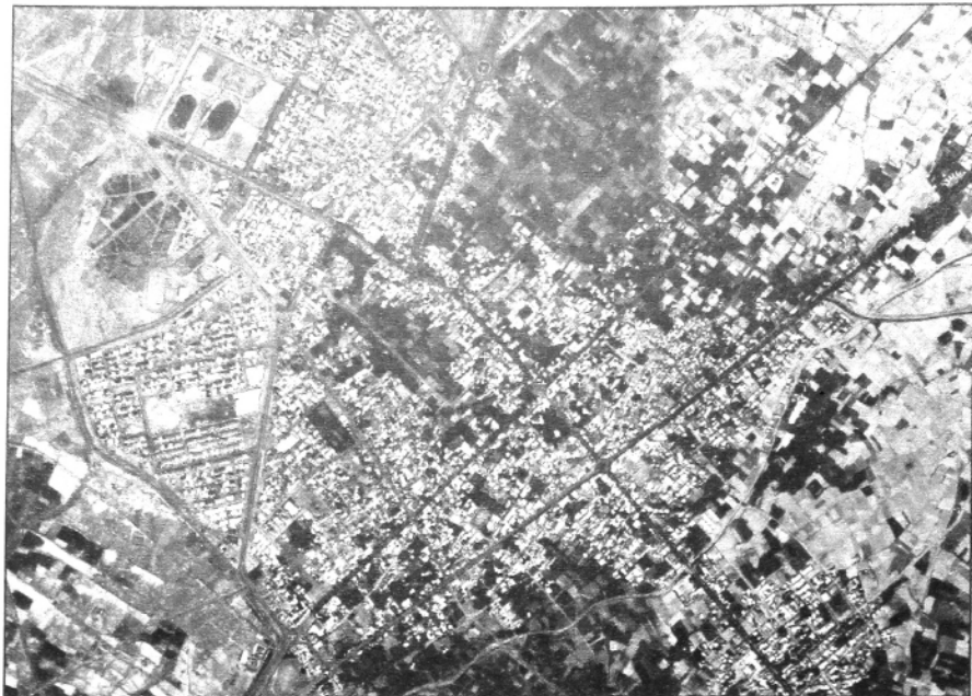
« تصویر هوایی شهر گناباد »
