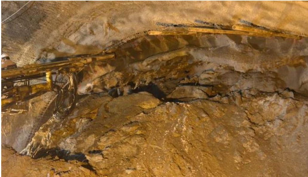
شکل ۴-۲ اجرای عملیات فورپولینگ به منظور افزایش پایداری توده
