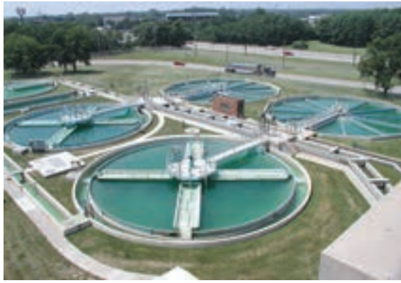
تصفیه آب در تصفیه خانه
