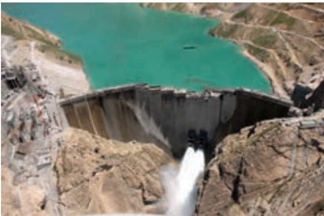
شکل ۶ - سد کارون ۴ - خوزستان
