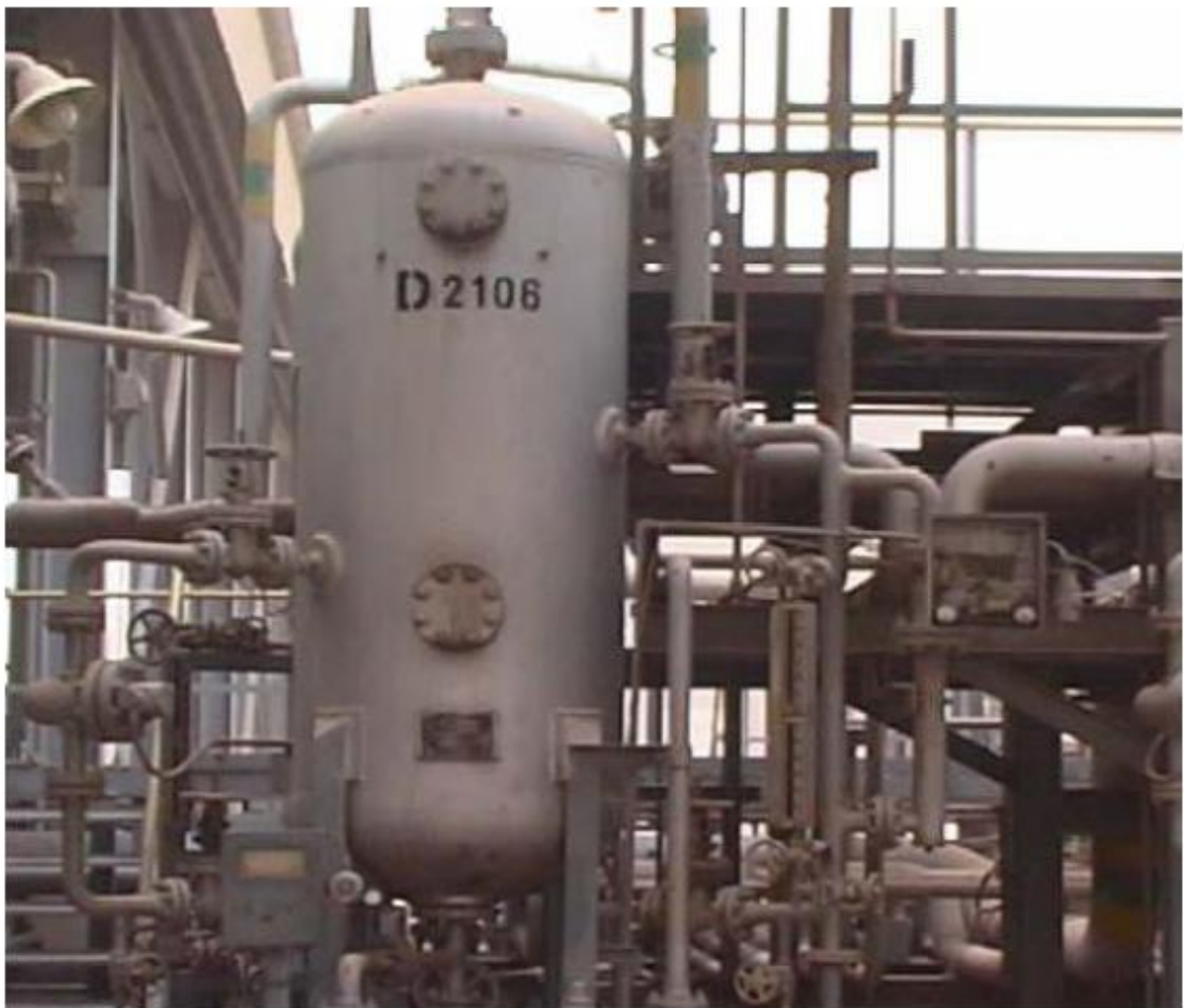
شکل ۴۱- نمایی از یک مخزن آبگیر
