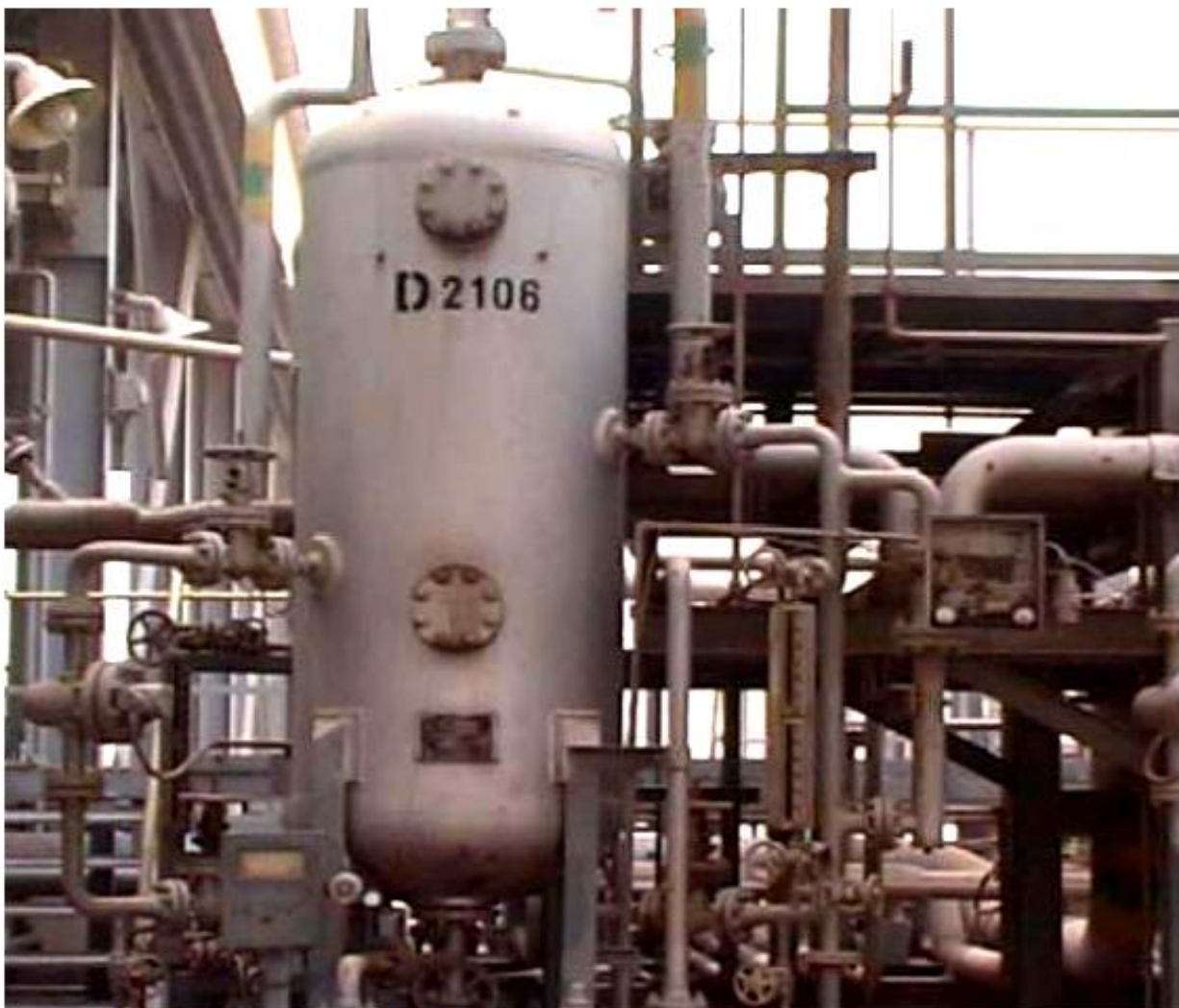
شکل ۴۱- نمایی از یک مخزن آبگیر
