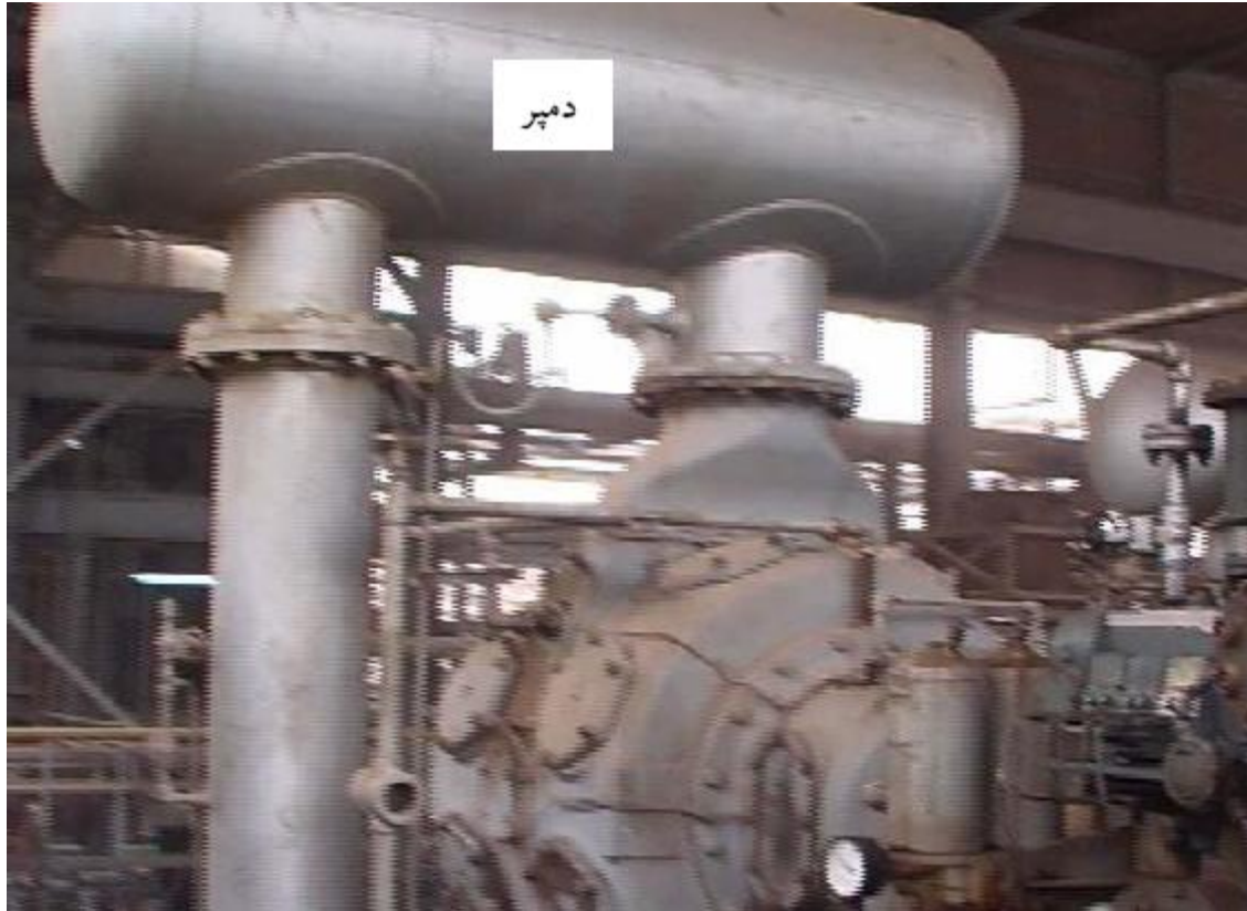
نمایی از دمپر ورودی یک کمپرسور رفت و برگشتی
