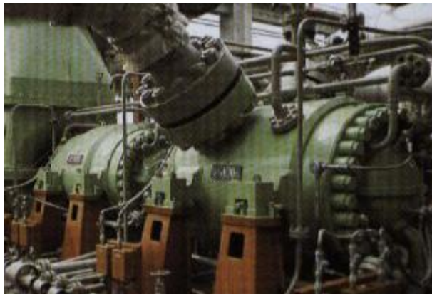
شکل ۹- نمایی از کمپرسور با محفظه عمودی
