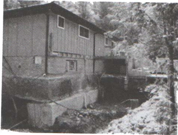
شکل ۲-۶-۱-۲: ساخت پی بزرگتر در زیر پی موجود
