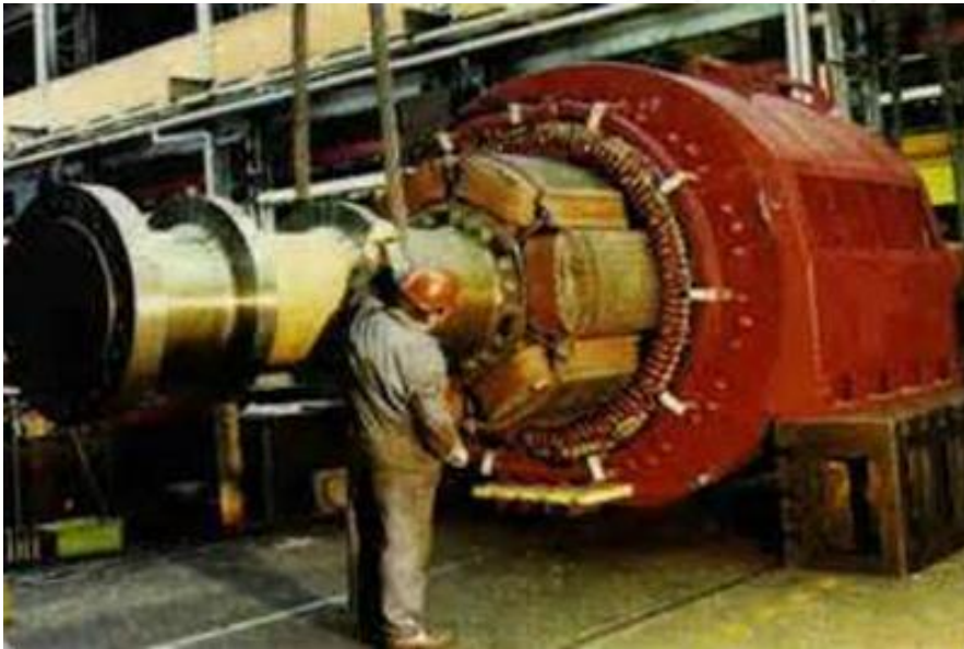
یک ژنراتور الکتریکی توان بالا در حال نصب
