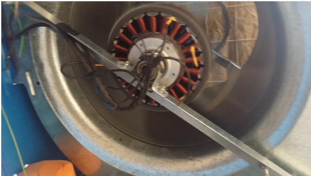
کولر آبی مجهز به موتور دایرکت درایو نوع براشلس DC با راندمان بالای ۸۵ درصد
