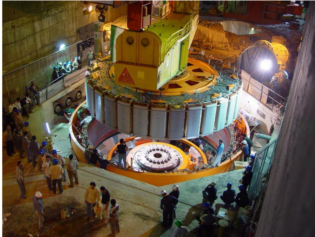
نصب روتور ژنراتور نیروگاه آبی
