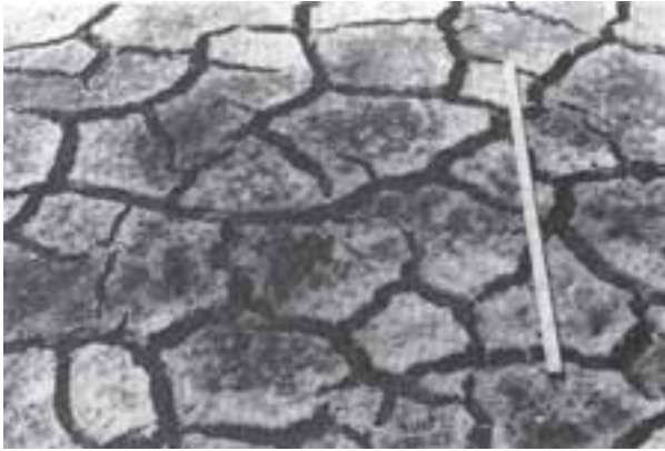
شکل ۱۹-۴- کف استخر پس از خشک کردن
