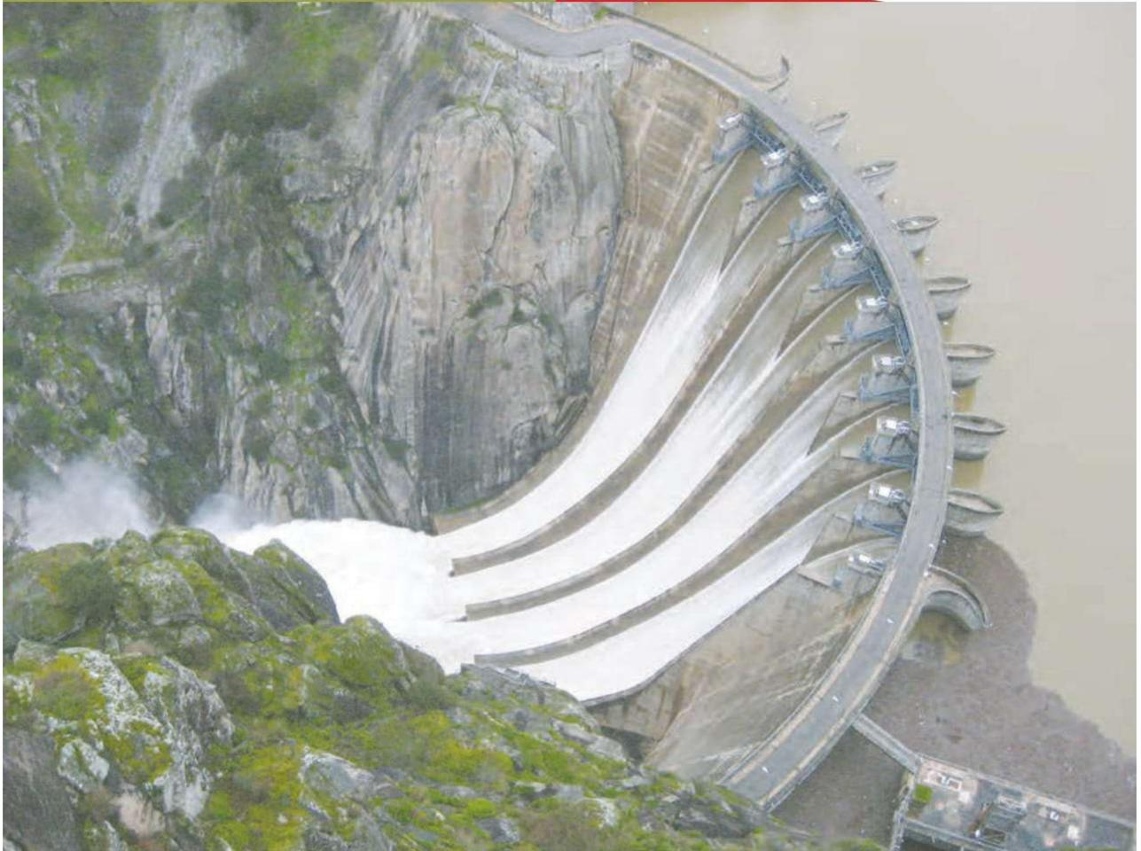
آب جمع شده در پشت سد، فشار زیادی به آن وارد می‌کند. آیا می‌دانید چرا هرچه از تاج سد به پایه آن نزدیک می‌شویم، ضخامت دیواره آن افزایش می‌یابد؟ با انجام دادن آزمایش کنید صفحه ۵۷، درک بهتری برای پاسخ به این پرسش پیدا خواهید کرد.
