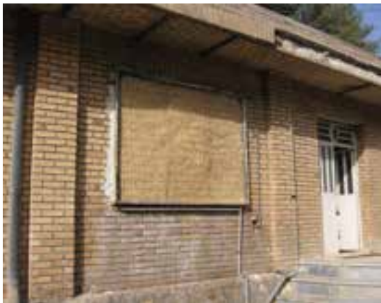
تصویر ۱۳-۲- انواع سیستم پوشال و هواکش
