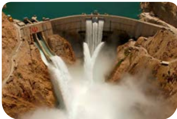
شکل ۲- سد و نیروگاه آبی کارون ۳ استان خوزستان
