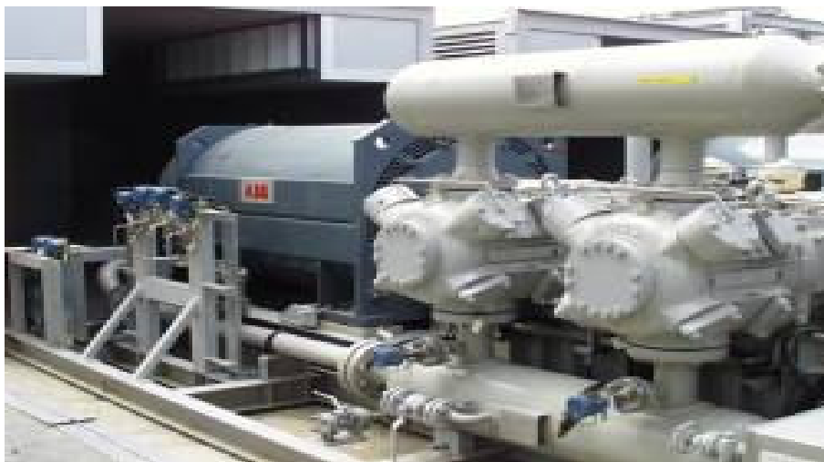
نمای ظاهری کمپرسور رفت و برگشتی با مخازن نوسان گیر ورودی و خروجی
