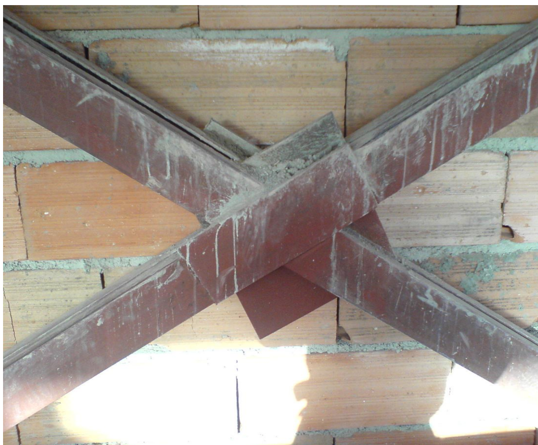
اتصال بادبند به محل اتصال تیر و ستون/اتصال بادبند ها در محل تقاطع پرو فیل هلی بادبند
