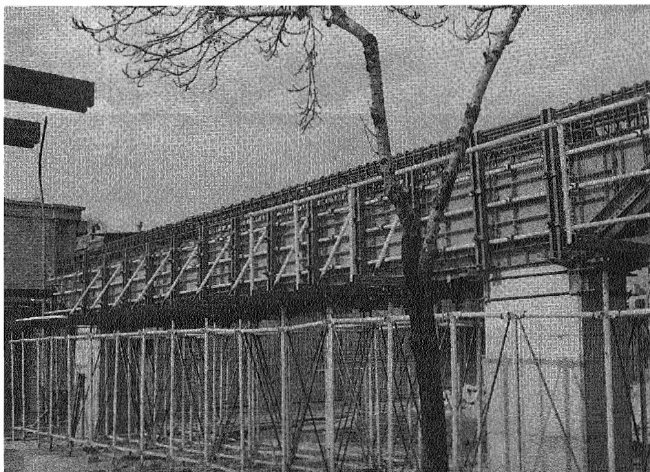
شکل ۸-۹ داربست‌بندی واقعی در زیر تیر سنگین.
