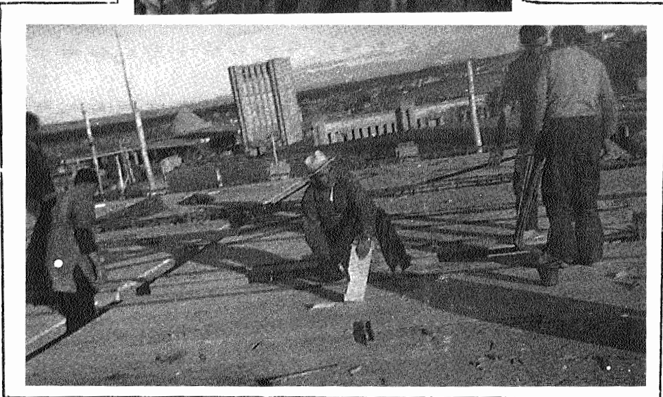
شکل ۱-۲ قالب بندی سنتی با چوب.
