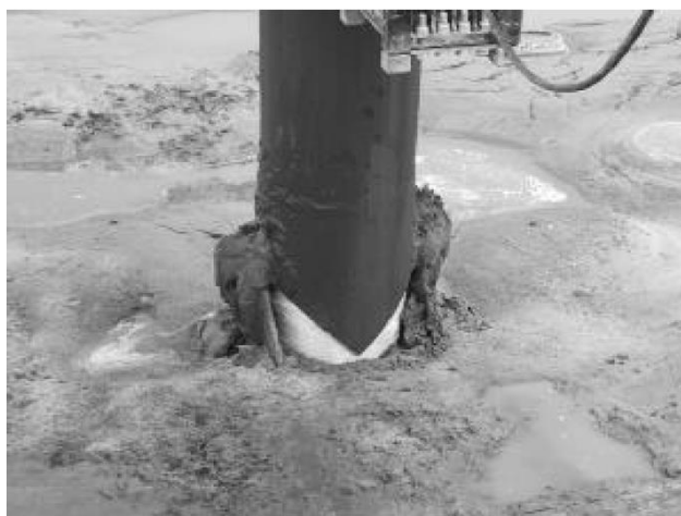
شکل ۱۷- نصب و راه اندازی به روش جابجایی ارتعاشی بواسطه اسکله شناور دور از ساحل
