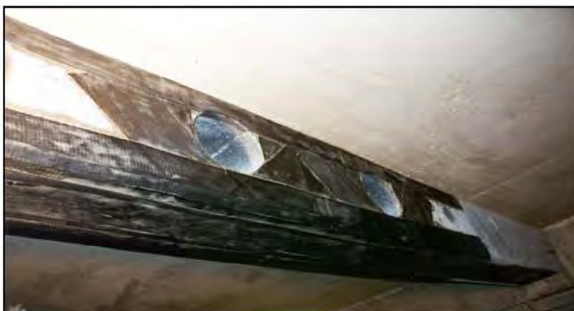
شکل ۲-۴-۱۵- تقویت موضعی سوارخ‌ها در تیر FRP
