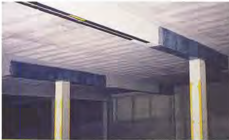
شکل ۲-۴-۸- کاربرد مصالح FRP در مقاوم‌سازی
