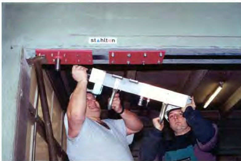
شکل ۲-۴-۱۷- روش پیش‌تنیدگی در صفحه FRP
