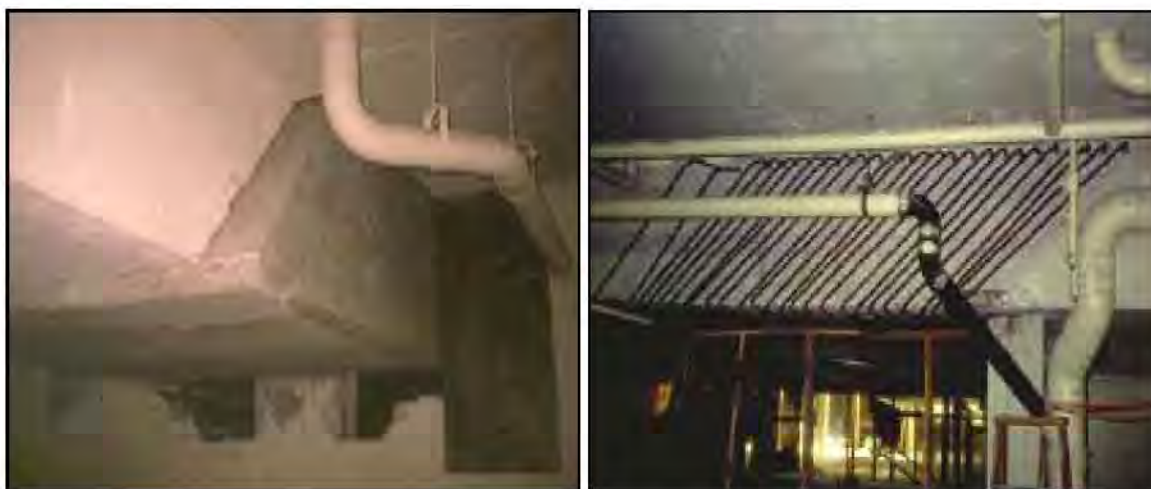
شکل ۲-۴-۴- استفاده از روکش بتنی در مقاوم‌سازی تیرها
