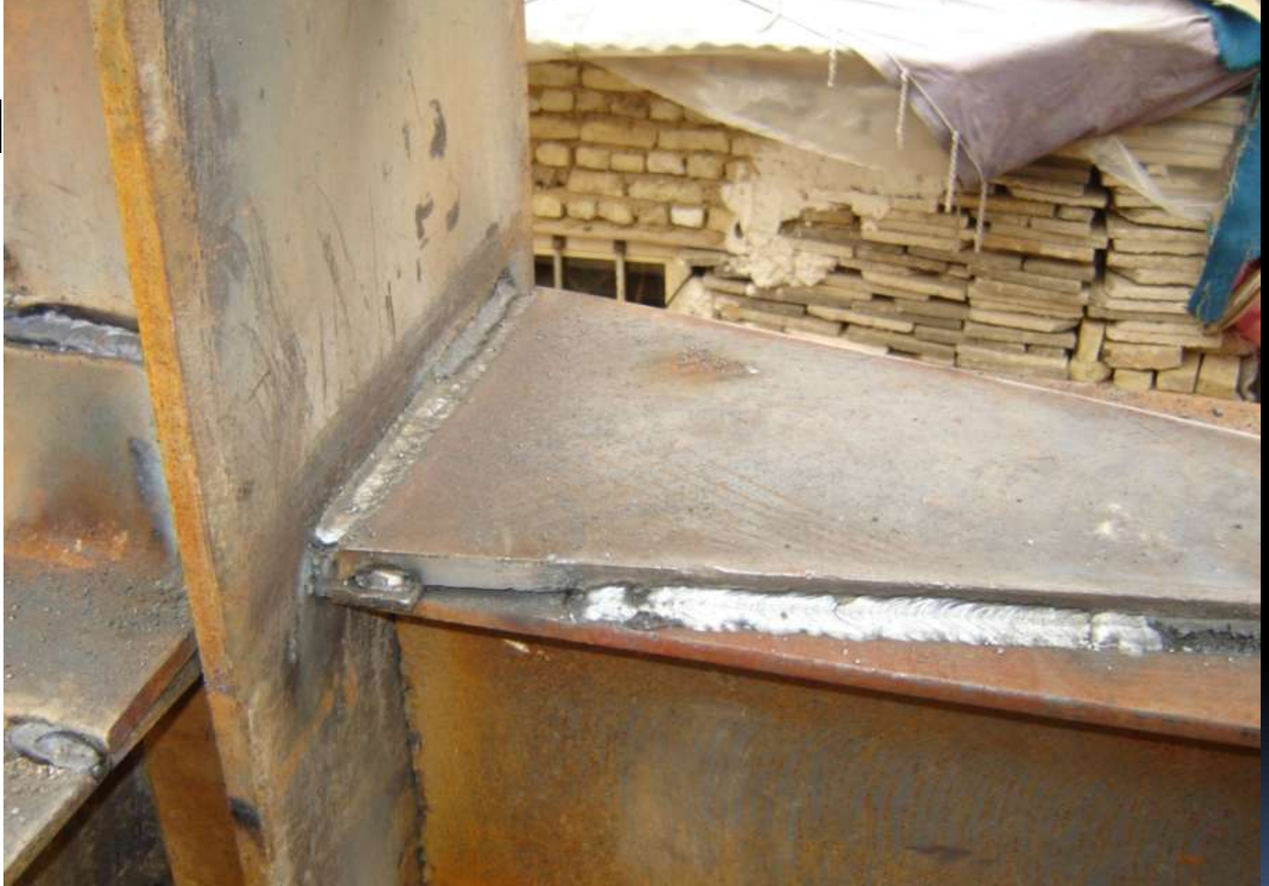
جوشکاری ورق روسری همراه با تسمه پشت بند
