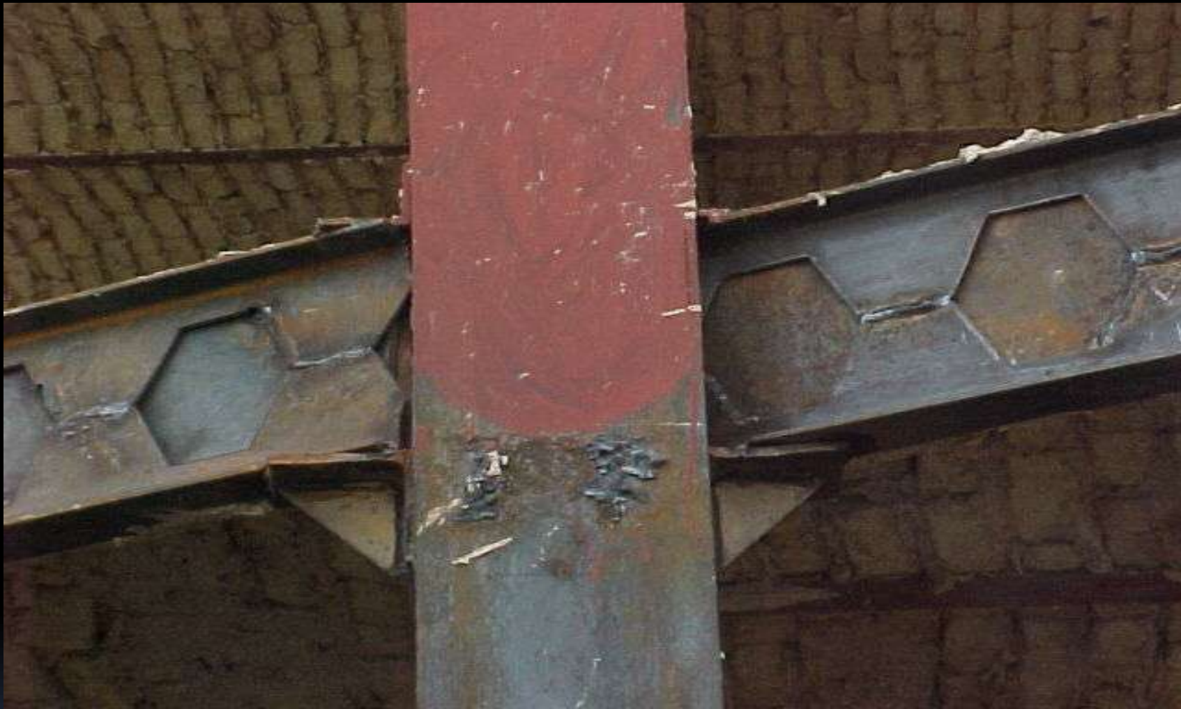
اتصال تیر به ستون دارای خروج از مرکزیت و عدم تأمین طول جوش کافی و مناسب
