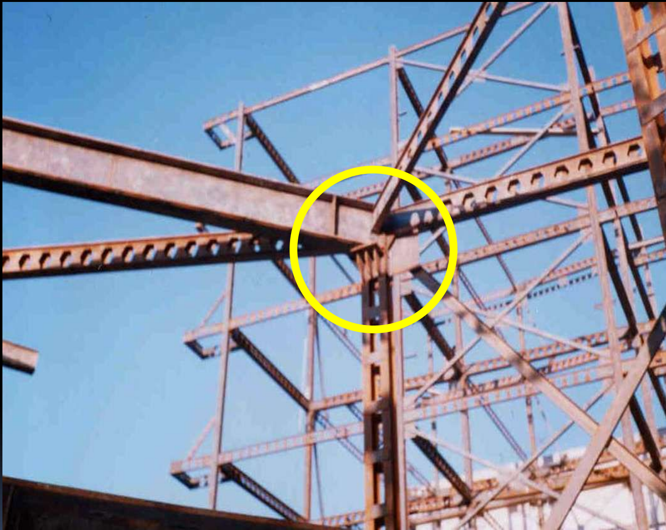
اتصال تیرهای متعدد از اطراف به ستون و کمبود مقاومت برشی چشمه اتصال
