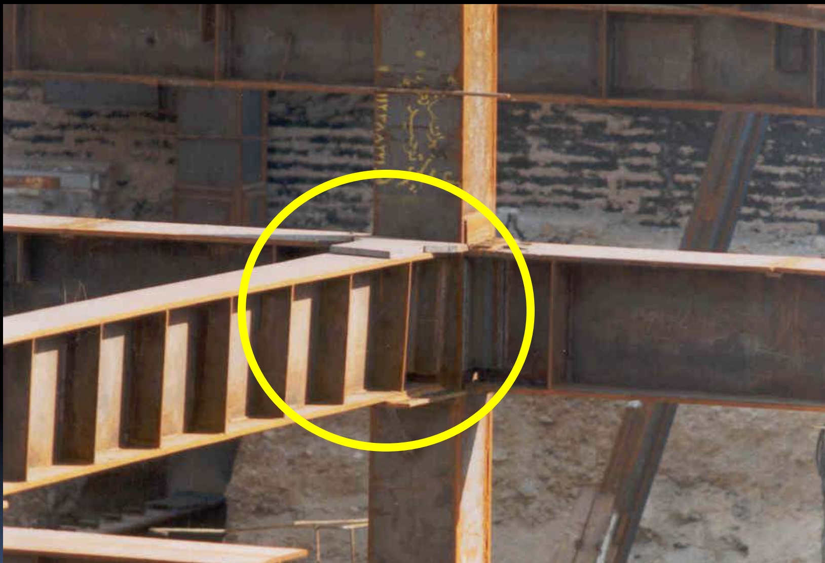
اتصال صلب تیر به ستون با ورق‌های فوقانی و تحتانی
