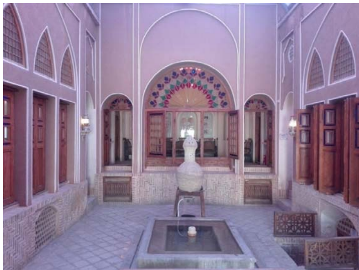
تصویر 29 حوضخانه، درهای چوبی، دریچه‌های هوا، سرداب و شیشه‌های مشبک خانه تاج
