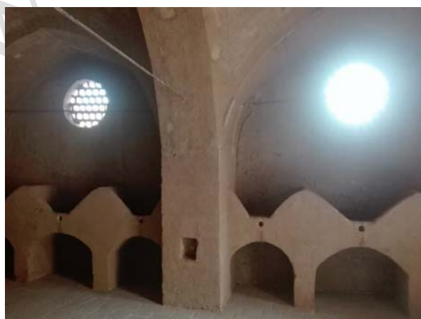
تصویر 9 نورگیری و هواکش‌های خانه طباطبایی‌ها
