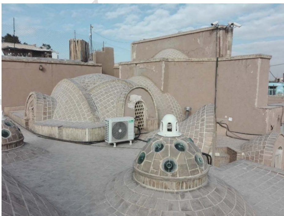
تصویر 42 نمایی از سقف گنبدی شکل و نورگیرهای حمام سلطان میراحمد
