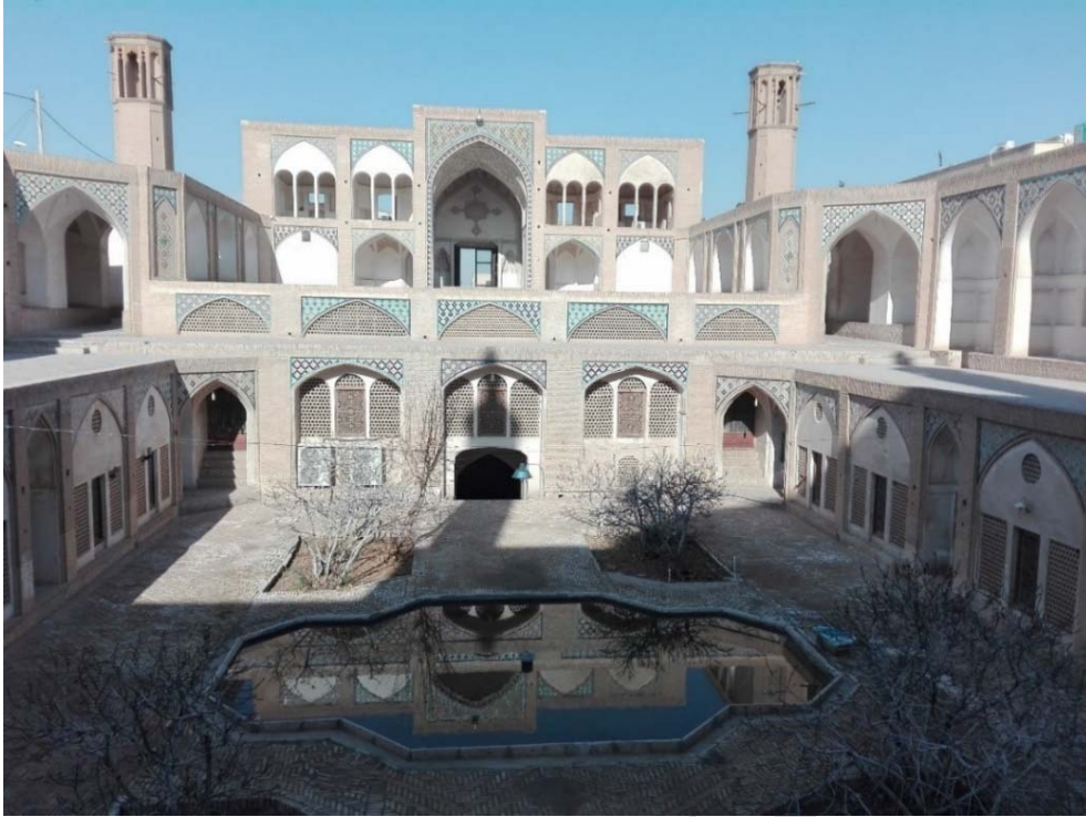
تصویر 45 نمایی از گودال باغچه، حوض، درختان، زیرزمین، دریچه‌های هوا و بادگیرها
