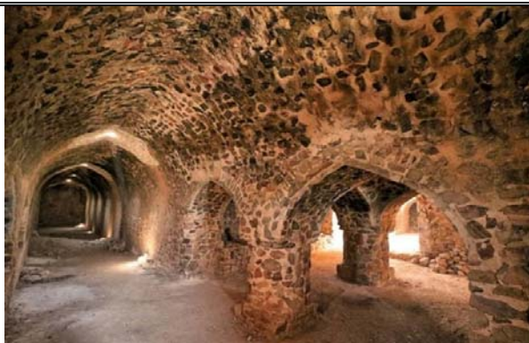
تصویر 80 کاروانسرای رباط قلی جاجرم، نورگیری، نمای شبستانی و استفاده حداکثری از مصالح طبیعی
