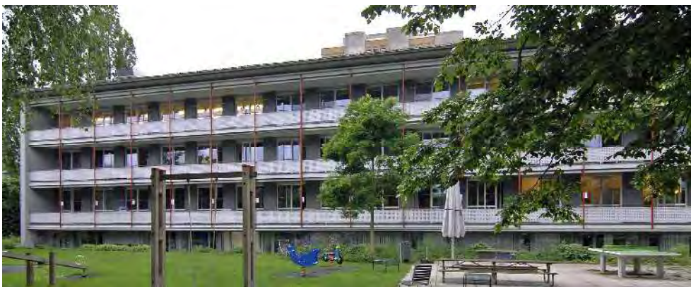
نمای طولی ساختمان در سمت زمین بازی کودکان.
