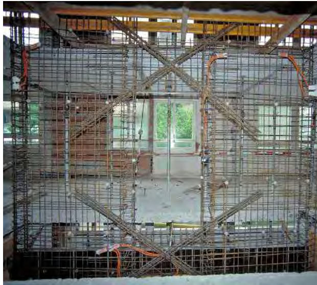
آرماتورگذاری افقی و قائم دیوارهای همبسته بتن مسلح در تراز همکف و آرماتورهای قطری دسته‌شده در تیرهای پیوند (تیرهای بالا و پایین).
