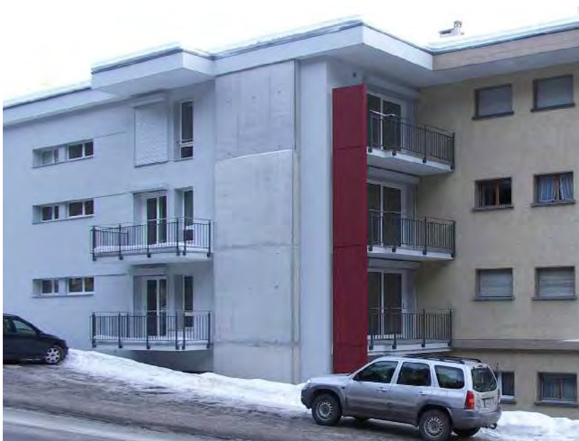
نمای شمالی ساختمان و دیوار پیرامونی بتن مسلح جدید.
