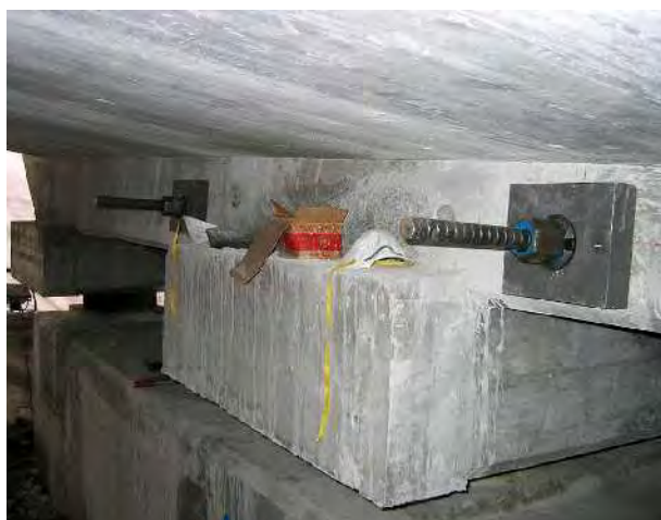
یکپارچه نمودن دو نیمه پل در محل درز انبساط موجود بر روی دهانه میانی.
