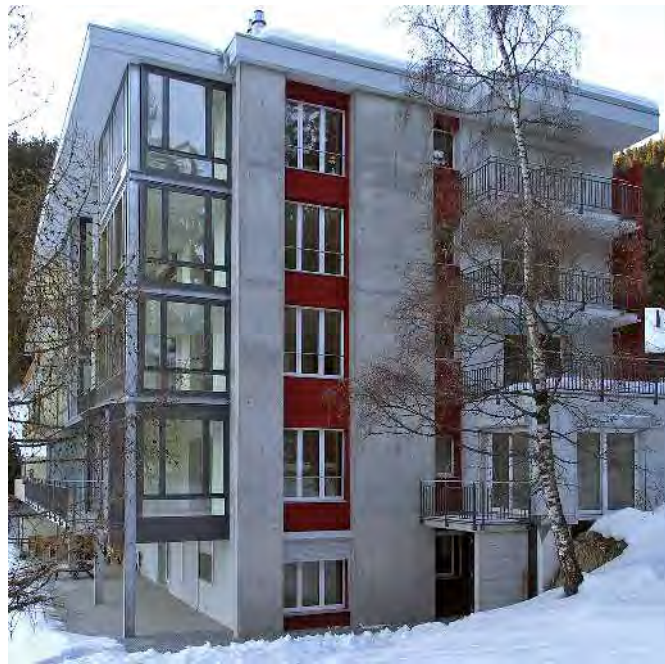
نمای شرقی ساختمان با دیوارهای پیرامونی جدید بتن مسلح.
