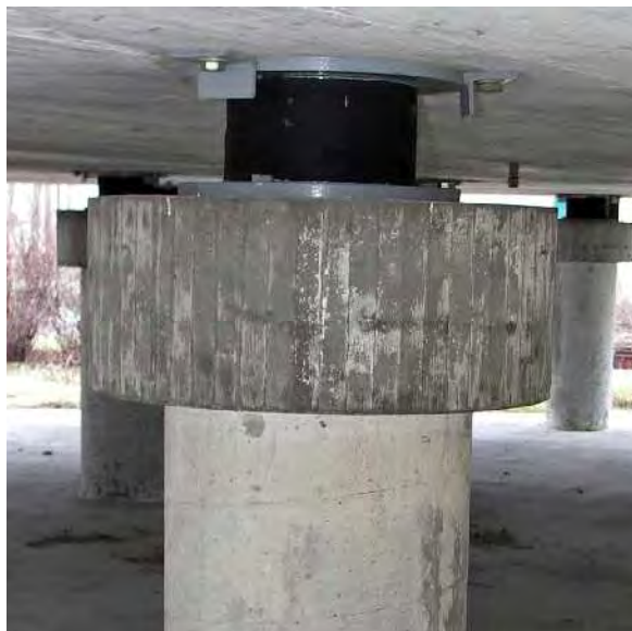
مقاوم‌سازی با نصب بالشک‌های لاستیکی در زیر مخزن فولادی گاز مایع و در بالای ستون‌ها.
