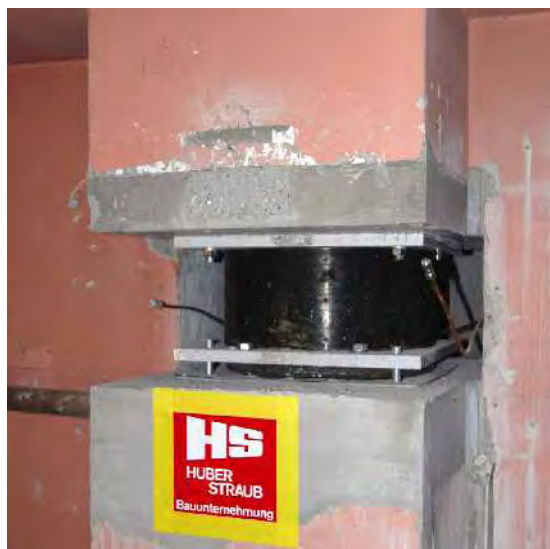
نصب بالشتک لرزه‌ای در زیرستون در وجه بیرونی دیوار زیرزمین.
