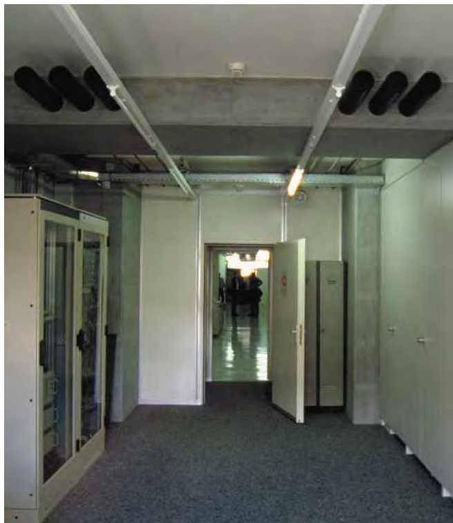
مهار انتهایی ۶ کابل کششی در تیر عرضی بین دیوارهای I شکل جدید در بخش توسعه ساختمان.
