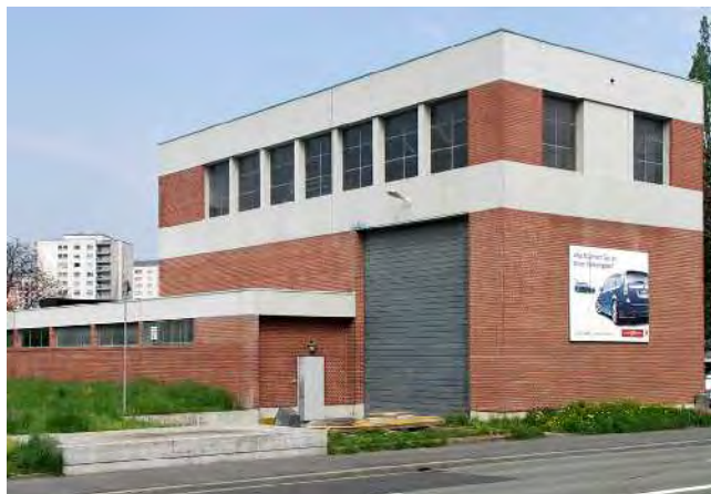
نمای خارجی تعمیرگاه الحاقی
