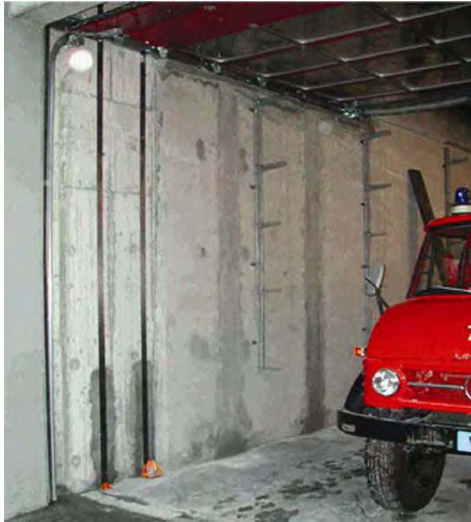
دو عدد از نوارهای CFRP پیش‌تنیده در وجه داخلی دیوارهای گوشه ساختمان (تروفور و همکاران، ۲۰۰۴)
