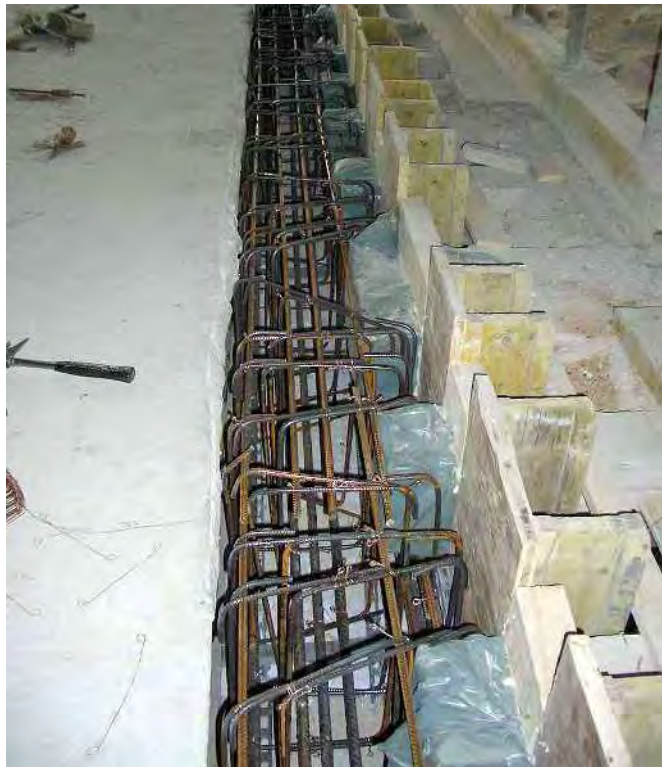
مهار آرماتورهای کف جدید در دیوارهای بنایی.
