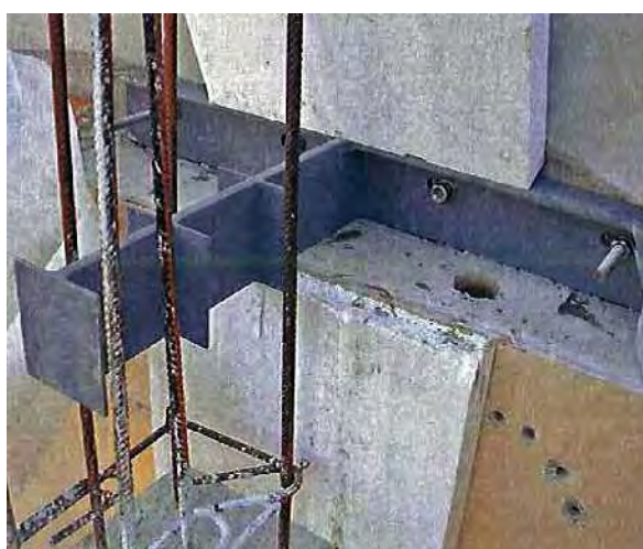
عناصر فولادی T شکل برای مهار دیوارهای بتن مسلح جدید در کف‌های موجود.
