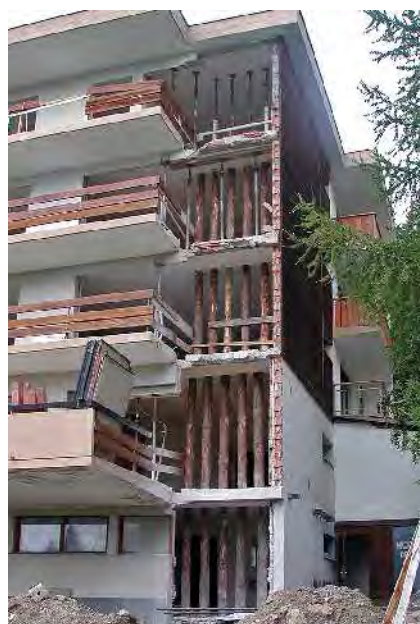
عملیات اجرایی در کنج جنوب شرقی ساختمان.
