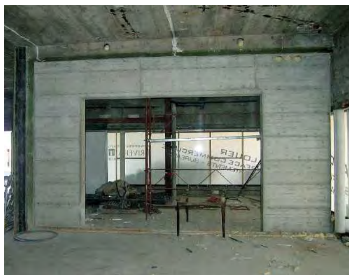
قاب بتن مسلح جدید در طبقه همکف.
