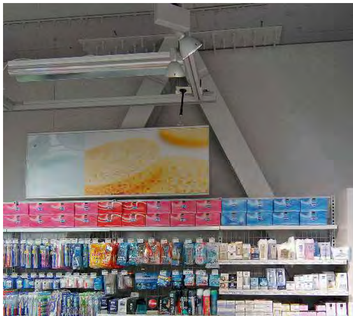
عضوی از خرپای فولادی V شکل جدید در اتاق اداری طبقه همکف.
