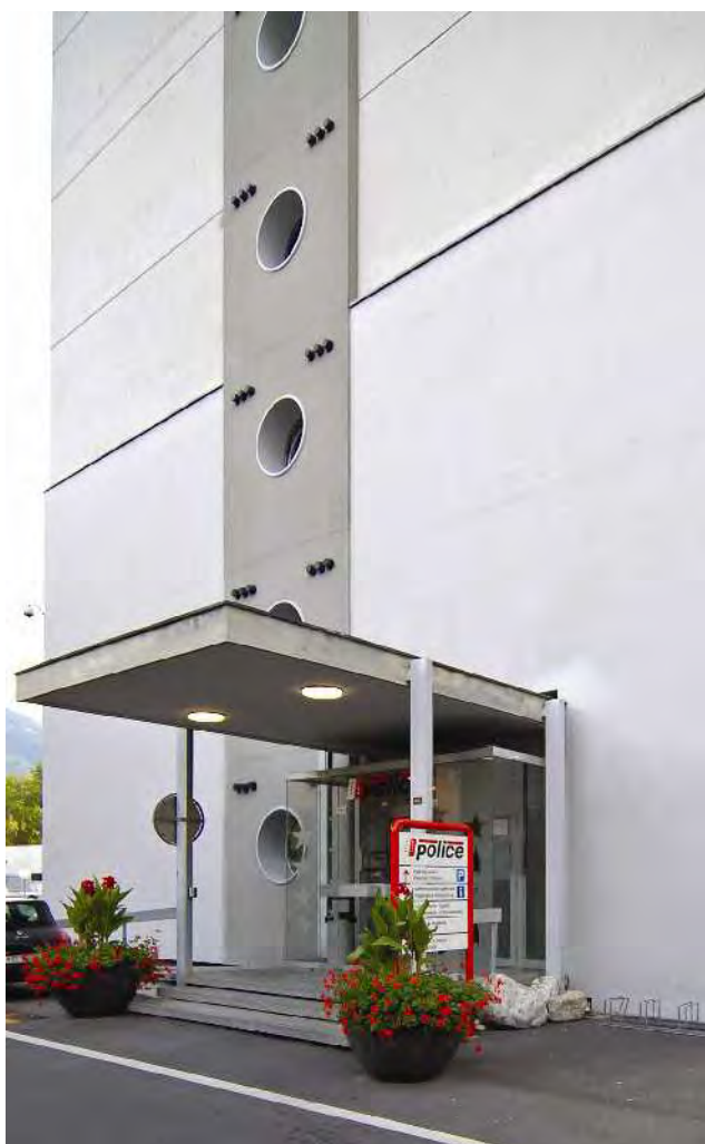
نمای بیرونی ساختمان در امتداد عرضی که مهار کابل‌های کششی در سطح بیرونی و در تراز هر طبقه را نشان می‌دهد.
