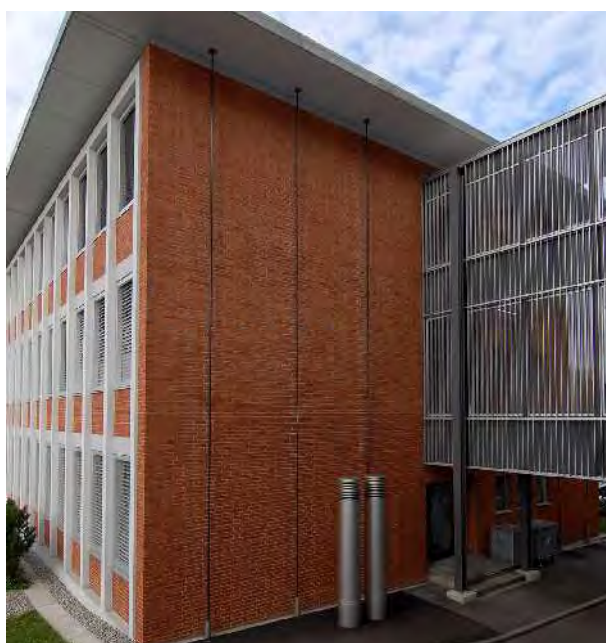
تقویت نمای شمالی با استفاده از میله‌های کششی ایف کربن.
