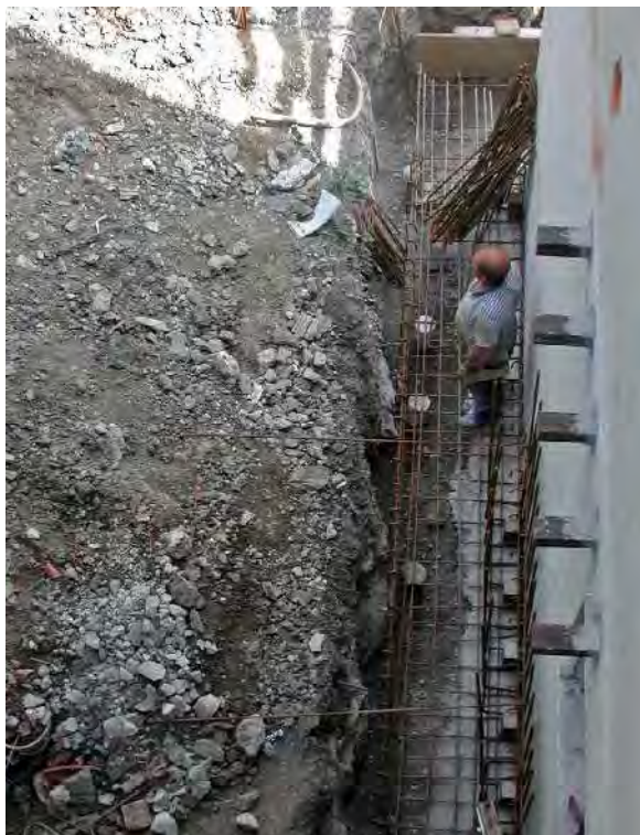
پی دیوارهای بتن مسلح جدید.
