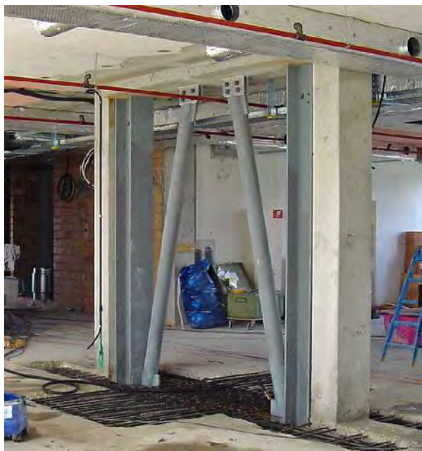
قاب‌های فولادی جدید واگرا که بین دو ستون بتن مسلح اجرا شده‌اند.
