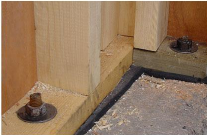
اتصال تیر تهنه‌ای دیوار به فونداسیون و پیچهای مهاری
