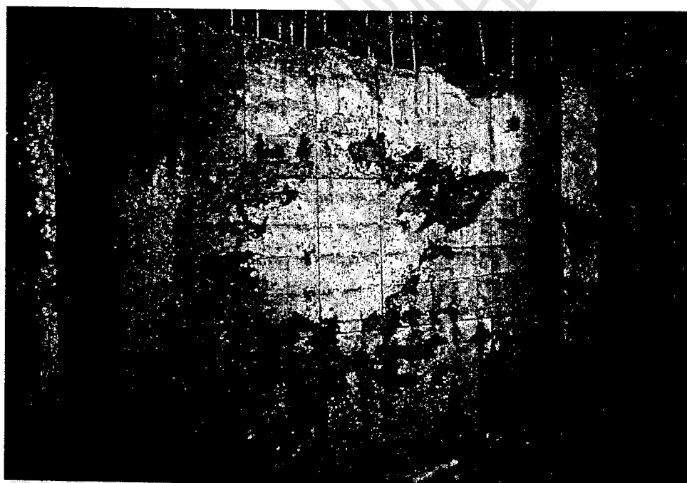
شکل (۴-۵) کرمو شدن بتن
