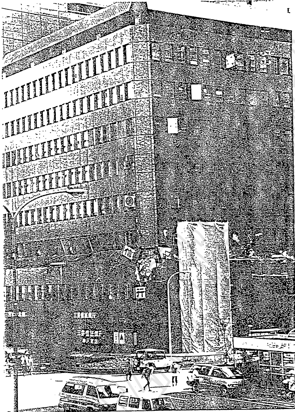
تصویر(ح) تخریب طبقه میانی ساختمان بلند به دلایل ۳،۴،۱ این ساختمان تقریباً روبروی ساختمان شهرداری کوبه
