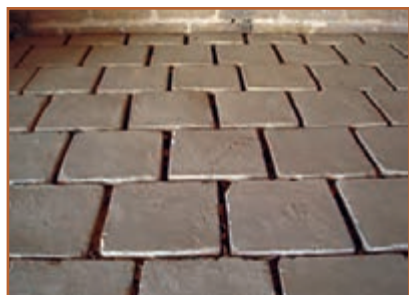
ب- استفاده از آجر برای کف
