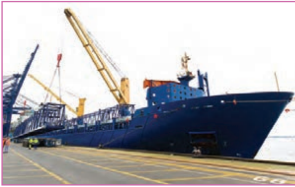
الف - نصب جرثقیل بر روی کشتی
