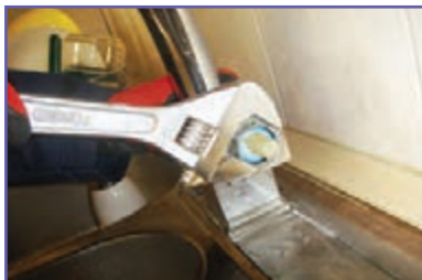
ث- باز کردن پیچ روی مغزی (گلند)
