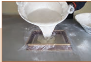
ث - ریختن ملات گچ در قالب
