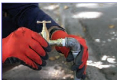
ت- بستن شیر با دست به لوله
