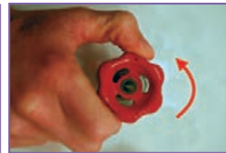
ح - باز کردن شیر فلکه اصلی
