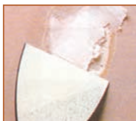
ب - لکه گیری و ترمیم ترک‌ها
