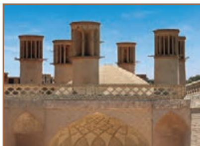
الف- استفاده از آجر در ساختمان‌های قدیمی
