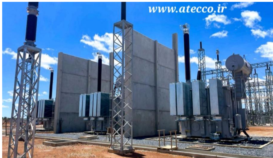
شکل (۵-۱): سه ترانس تک فاز به عنوان یک مجموعه ترانس سه فاز
