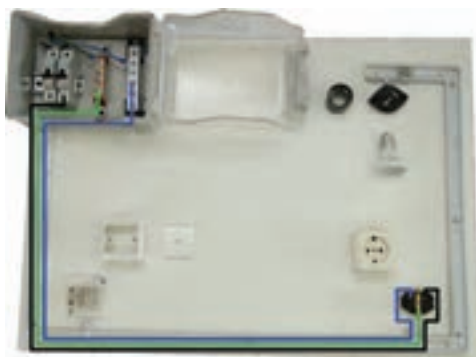
شکل ۵-۱۰- انجام سیم‌کشی پریز ۱
