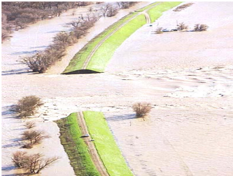
شکل ۲۷: تخریب خاکریز سیل بند در اثر بارندگی زیاد در بالادست
