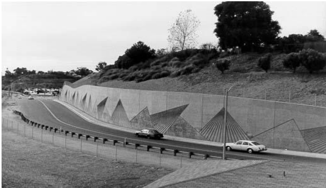
شکل ۱۱-۴: روکش ساخته شده در محل.
