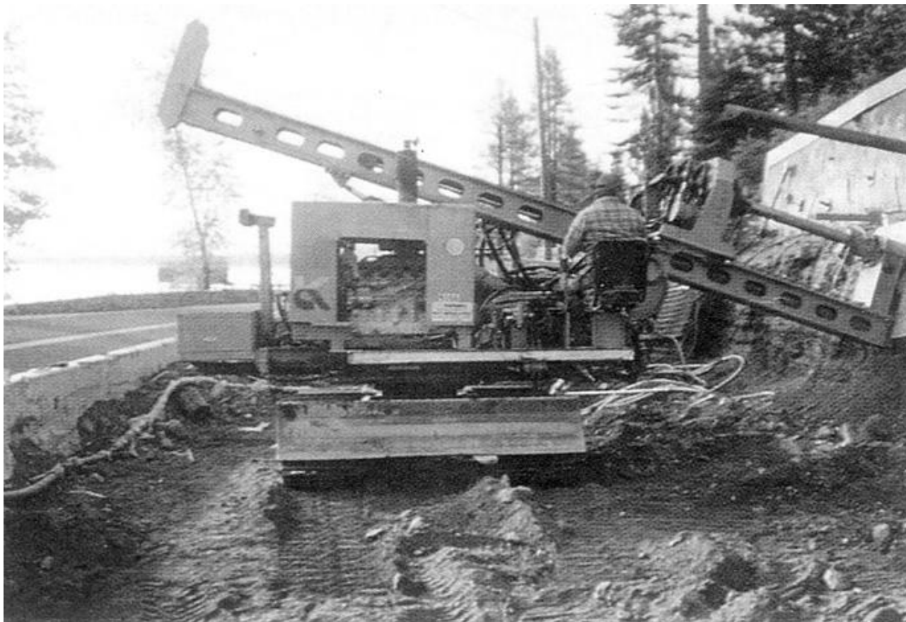
شکل ۸-۴: مته کاری برای میخ توسط روش چرخشی.
