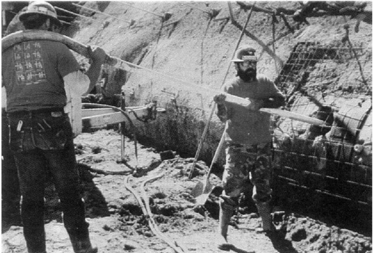
شکل ۲-۴: دوغاب ریزی از طریق لوله (تریمی).
