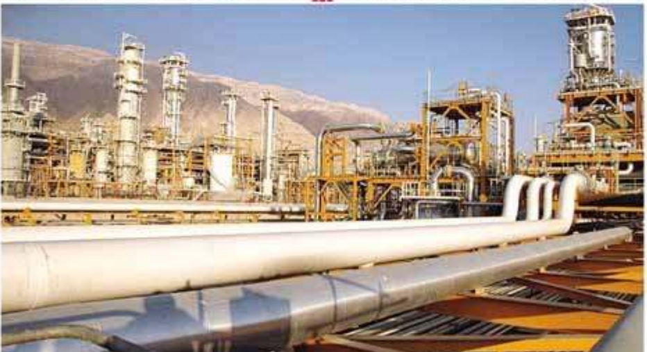
جزئیات آزمایشی گاز ۲ فاز پارس جنوبی اعلام شد
