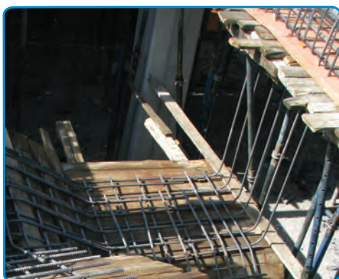
شکل ۴۱-۷- اجرای میلگردهای دال پله
