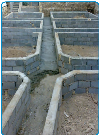
شکل ۶-۷- آماده سازی کف پی
