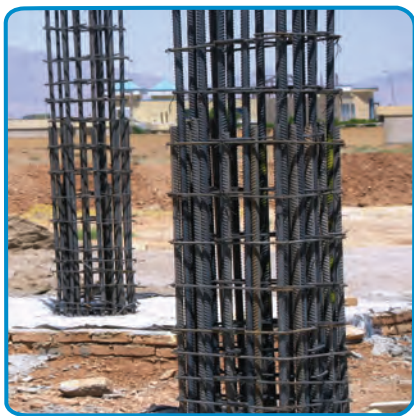
شکل ۱۶-۷- بتن ریزی ستون
