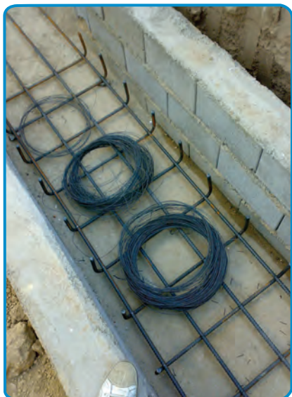
شکل ۹-۷- بهم بستن میلگردها
