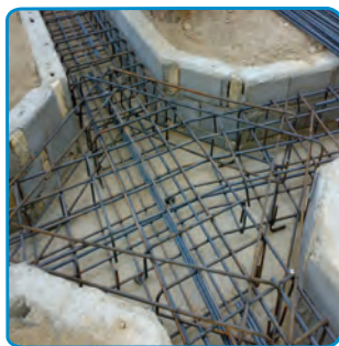
شکل ۱۴-۷- تکمیل میلگردگذاری محل اتصال ستون
