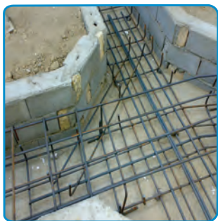
شکل ۱۳-۷- قرار دادن میلگردهای تقویتی پخها
