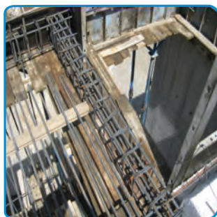
شکل ۷-۳۱- اجرای بازشودر سقف
