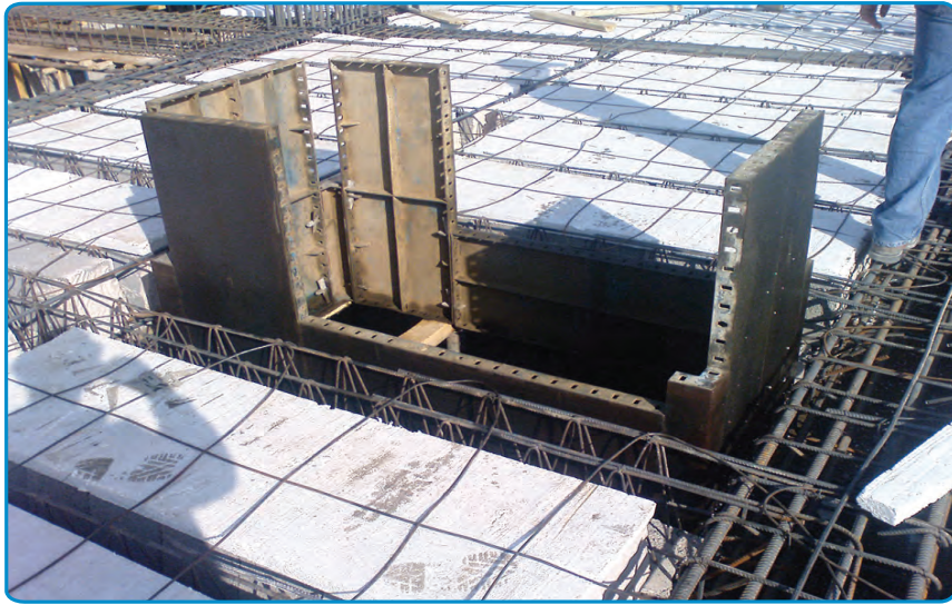
شکل ۳۵-۷- تکمیل قالب بندی
