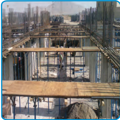
شکل ۷-۲۱- قالب بندی تیرها
