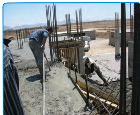
شکل ۴۲-۷- بتن ریزی دال پله
