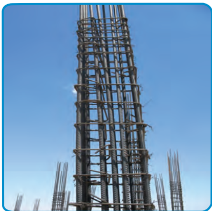
شکل ۱۹-۷- کار گذاشتن میلگردهای انتظار ستون، در فونداسیون
