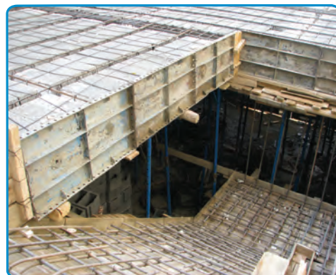
شکل ۴۰-۷- اجرای میلگردهای دال پله
