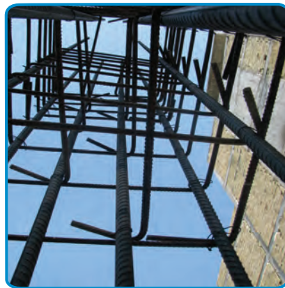
شکل ۱۹-۷- کار گذاشتن میلگردهای انتظار ستون، در فونداسیون
