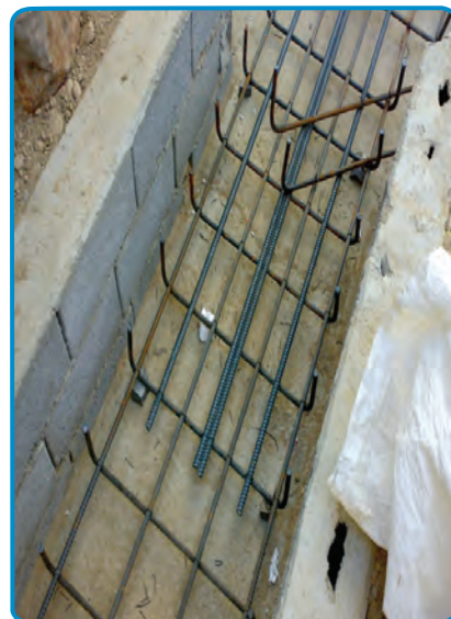
شکل ۱۱-۷- قرار دادن میلگردهای تقویتی
