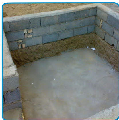
شکل ۱-۷- آماده سازی کف پی
