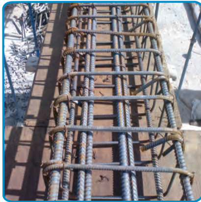
شکل ۷-۲۵- بستن خاموت ها با مفتول
