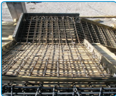
شکل ۳۷-۷- اجرای میلگردهای دال پله
