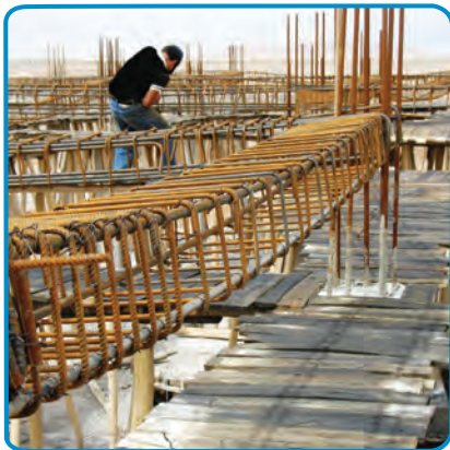
شکل ۷-۲۴- تنظیم فاصله بین خاموت ها
