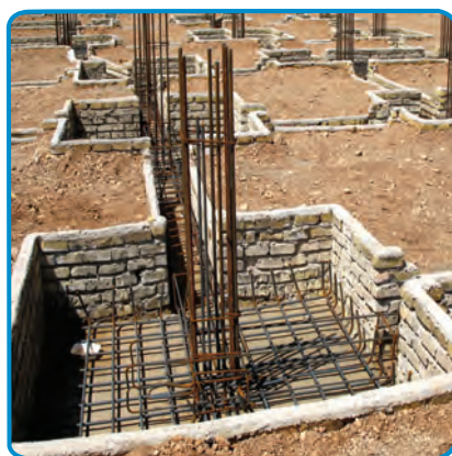
شکل ۴-۷- اجرای میلگردهای ریشه انتظار
