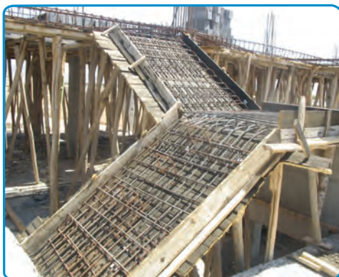
شکل ۳۹-۷- اجرای میلگردهای دال پله
