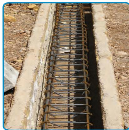
شکل ۵-۷- اجرای میلگرد شناژها
