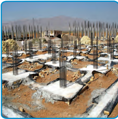
شکل ۱۷-۷- اجرای خاموت و سنجاقک
