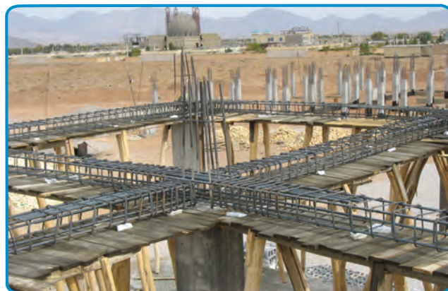
شکل ۷-۲۷- رعایت فاصله پوشش بتنی در کف
