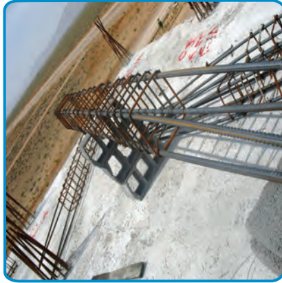
شکل ۷-۲۲- آماده کردن میلگردهای تیر روی زمین
