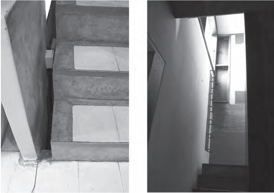
Figure 5.41 Stair Jaoul Maison B (1955)
