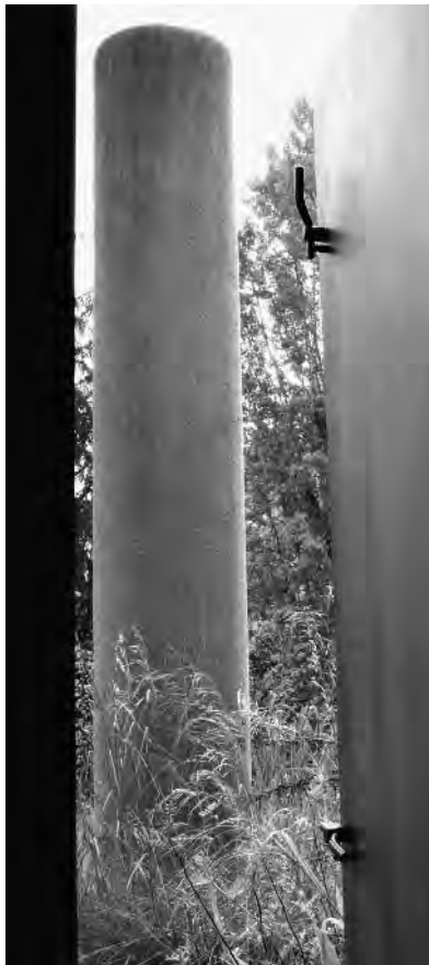
Figure 6.11 Chimney, Maison Jaoul B (1955)
